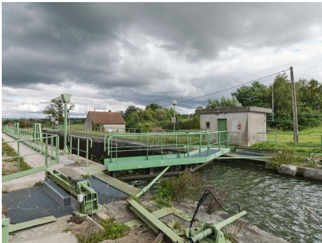
Vue rapprochée du site d'écluse, du sas de grande chute et du poste de commande.
