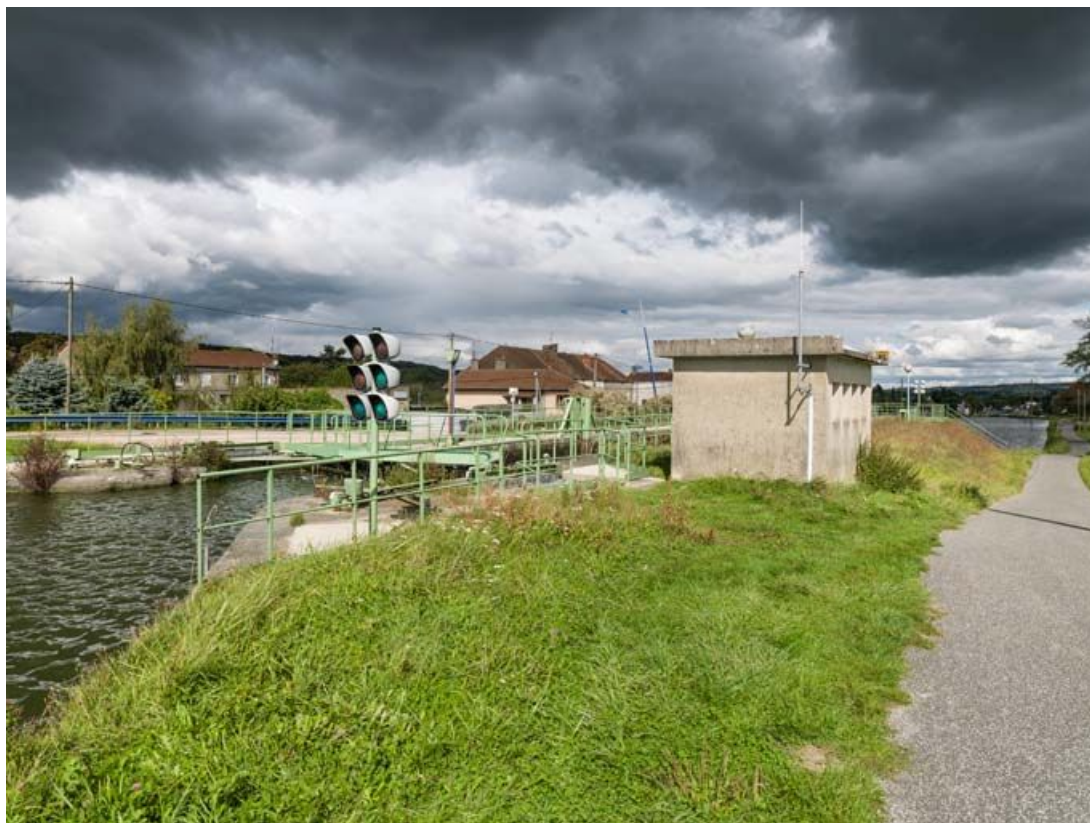
Vue d'ensemble du site d'écluse et du chemin de halage. 71, Écuisses, lieudit : bief 02 du versant Saône-Méditerranée
