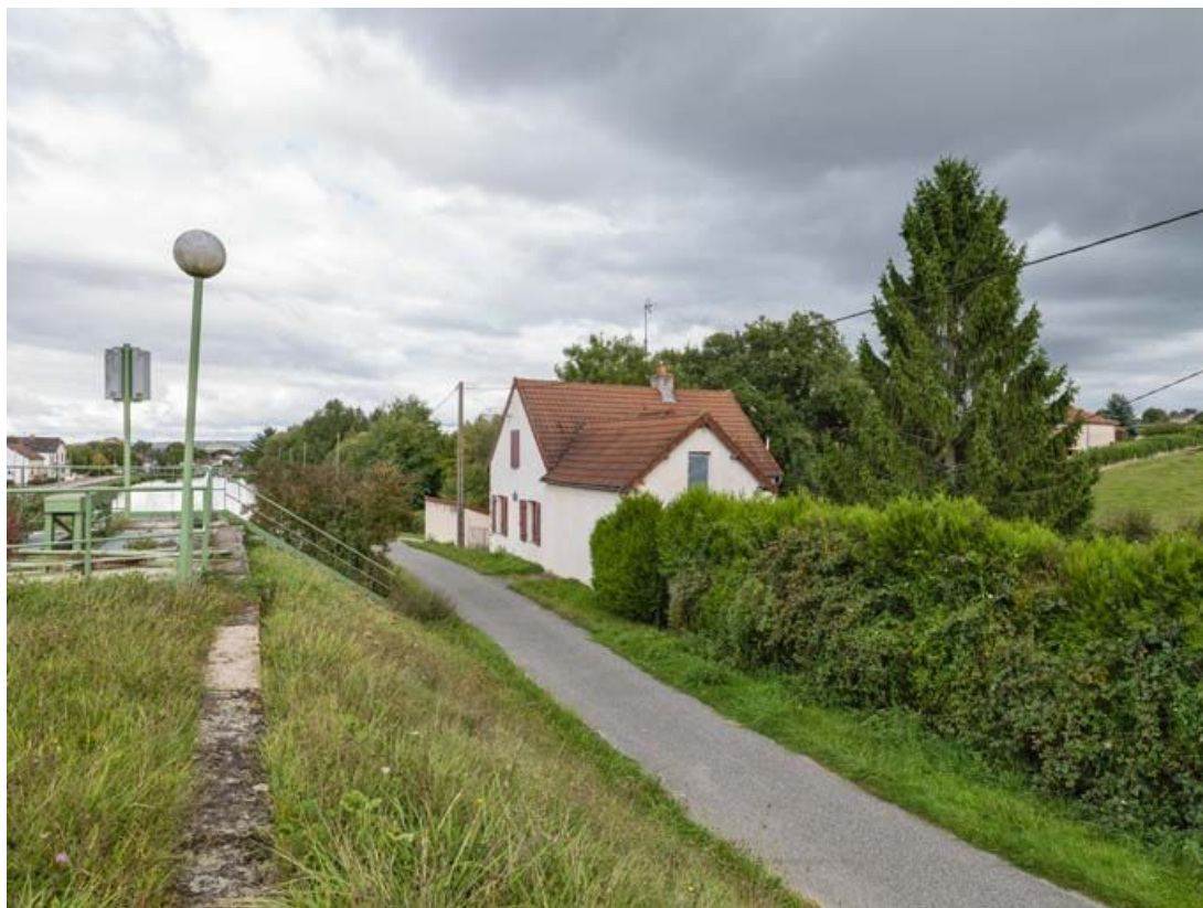
Vue de l'ancien site d'écluse et de la maison éclusière.
