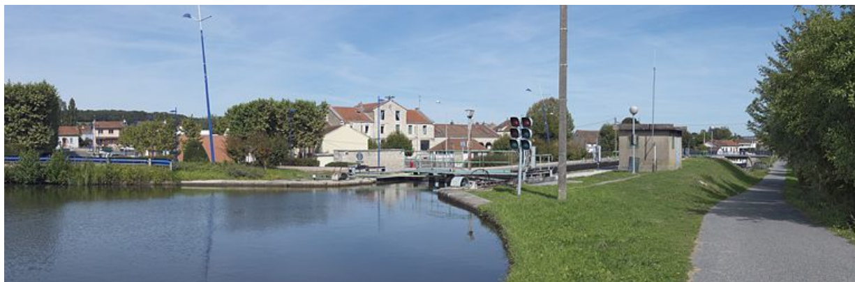
Vue d'ensemble prise d'amont du bord du canal à Écuisses avec la mairie et le site d'écluse 04. 71, Écuisses, lieudit : bief 05 du versant Saône-Méditerranée
