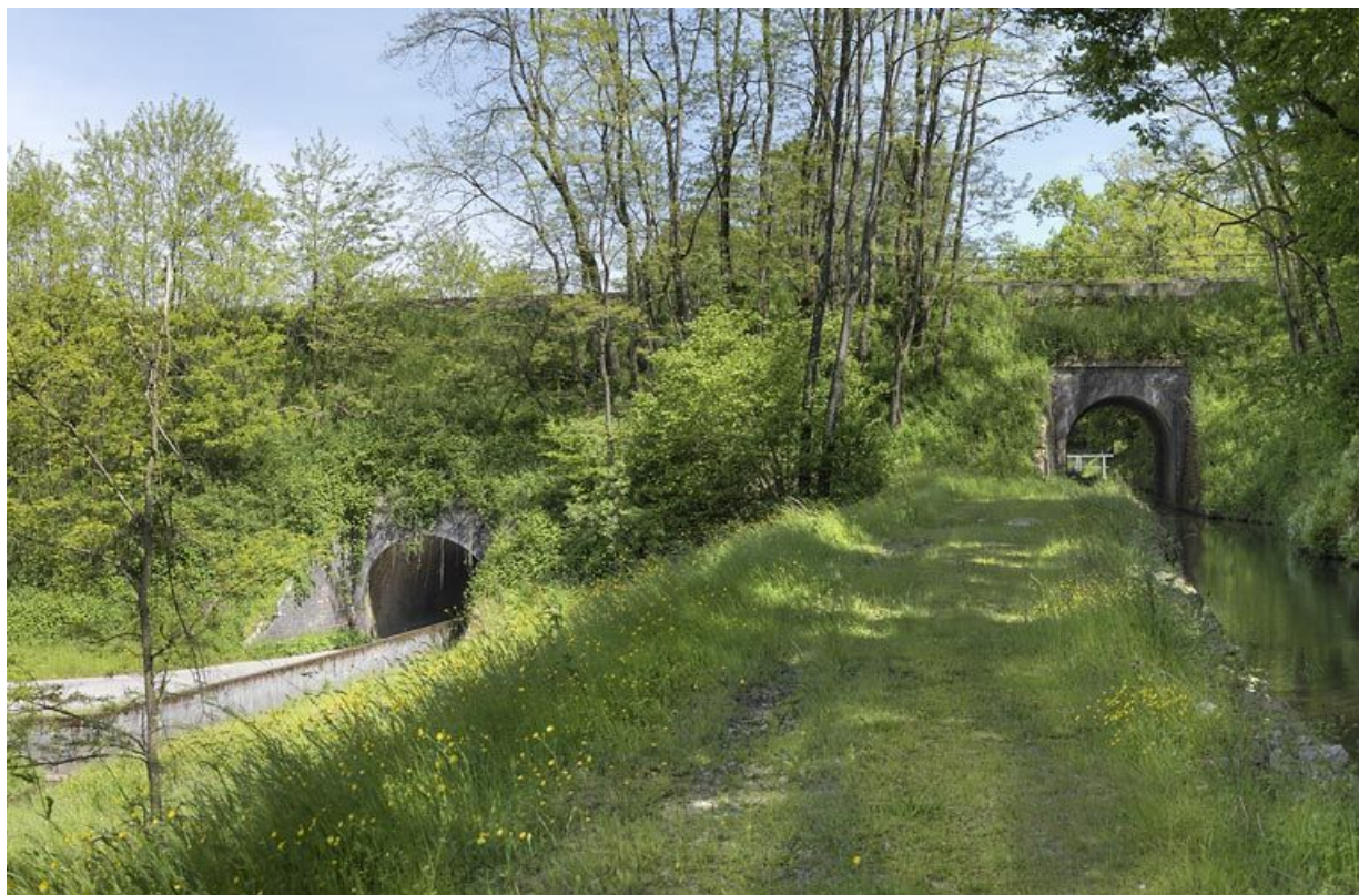
A gauche, la rigole de fuite et à droite la rigole d'alimentation avec le pont ferroviaire.
