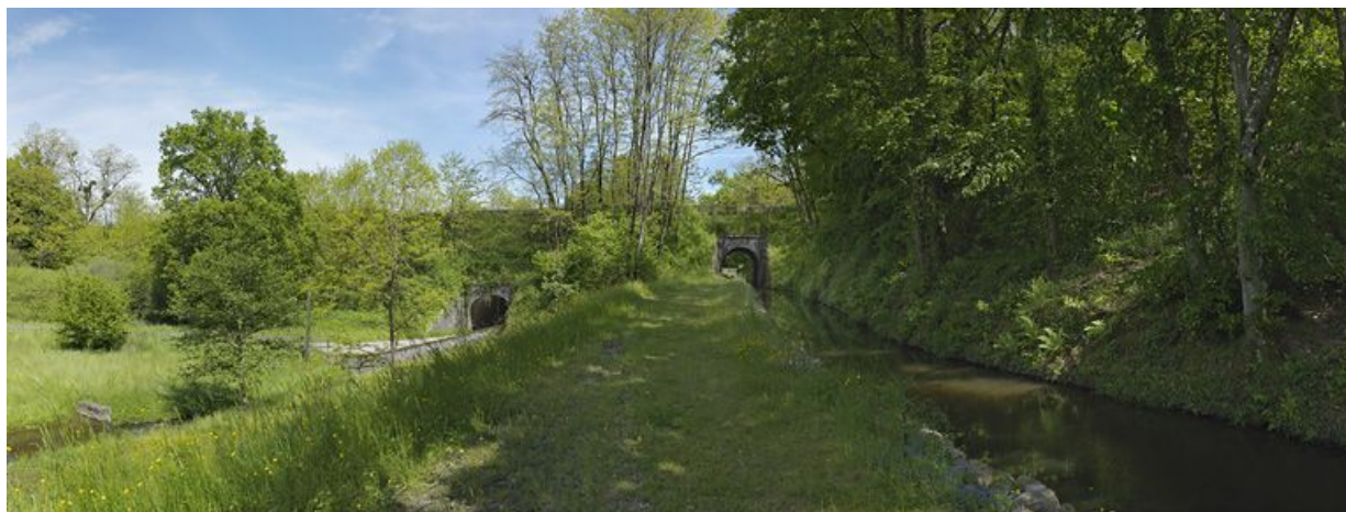
A gauche, la rigole de fuite et à droite la rigole d'alimentation avec le pont ferroviaire.
