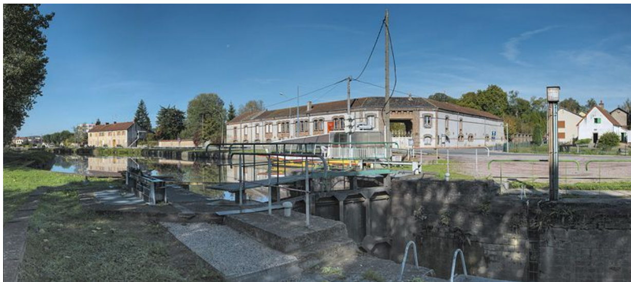
L'usine Perrusson. Au premier plan, le site d'écluse 06. A droite : l'ancienne maison éclusière IX du Musée du Canal. 71, Écuisses, lieudit : bief 06 du versant Saône-Méditerranée
