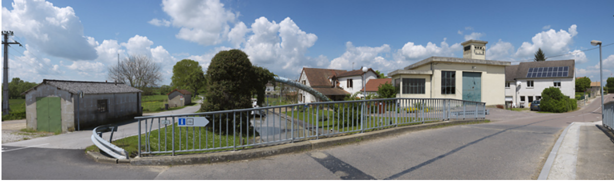
Vue d'ensemble du site de l'écluse 34 du versant Méditerranée à Fagnès, depuis le pont.
