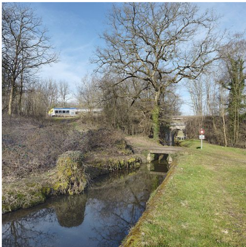
La rigole d'alimentation avec en arrière-plan le pont ferroviaire.
