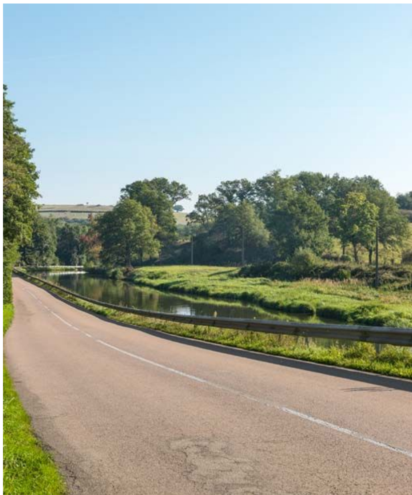
Vue de l'ancien site d'écluse, sans la maison éclusière aujourd'hui détruite. 71, Saint-Julien-sur-Dheune, lieudit : bief 10 du versant Saône-Méditerranée
