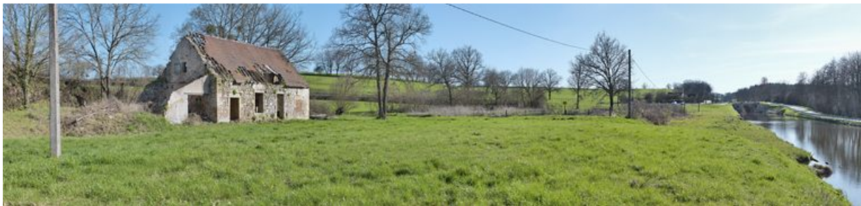
La maison éclusière avec à droite, le canal du Centre et en arrière-plan le site d'écluse 10.
