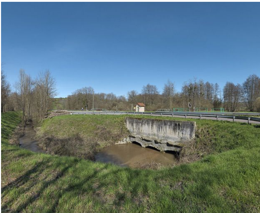
Vue de la sortie de l'aqueduc, de l'autre côté du canal.
