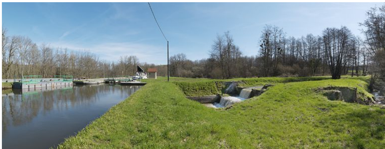
Vue d'ensemble du site avec à gauche, le site d'écluse. Au centre, l'ouvrage avec son palier. 71, Saint-Julien-sur-Dheune, lieudit : bief 11 du versant Saône-Méditerranée
