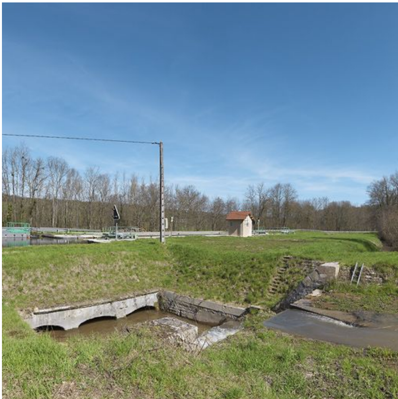
Vue d'ensemble de l'ouvrage avec en arrière-plan le site d'écluse.
