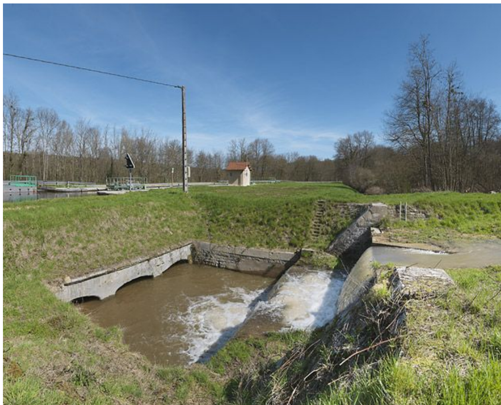
Vue d'ensemble de l'ouvrage avec en arrière-plan le site d'écluse.
