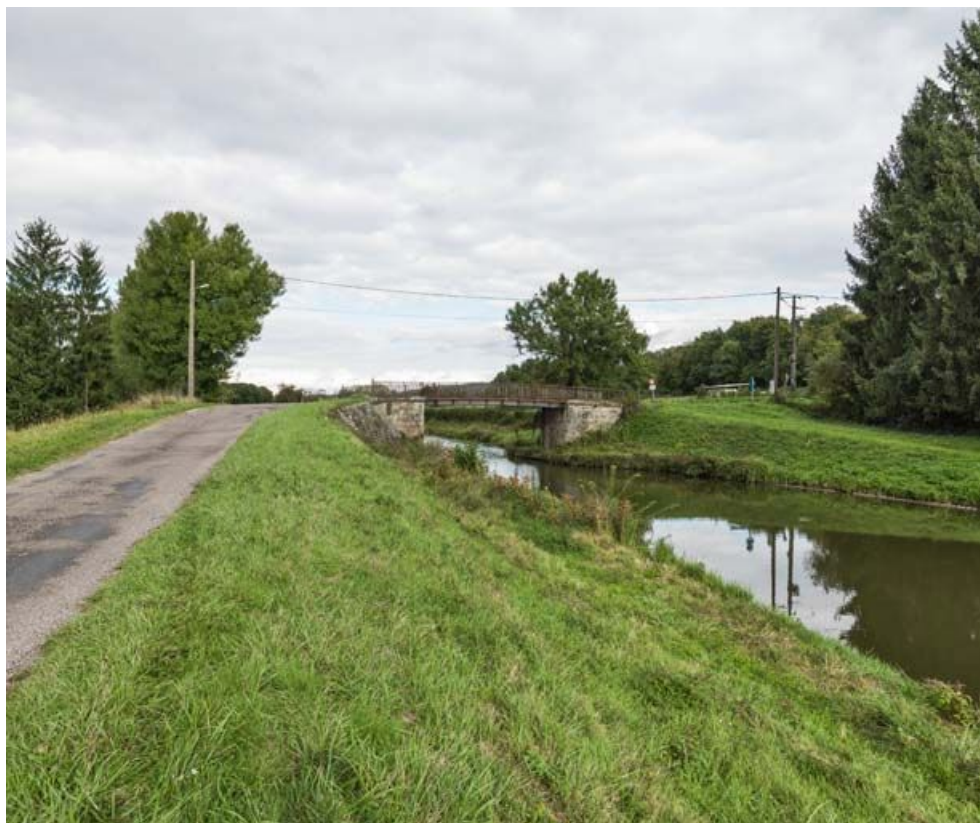
Vue d'ensemble du pont et du site.
