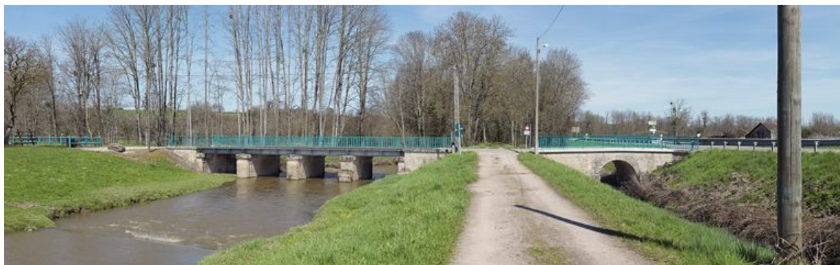
Le pont sur la Dheune. A droite, le pont sur contre-fossé.
