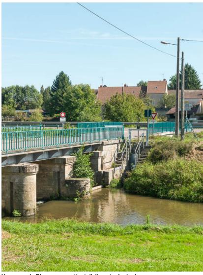
Vanne sur la Dheune permettant d'alimenter la rigole.
