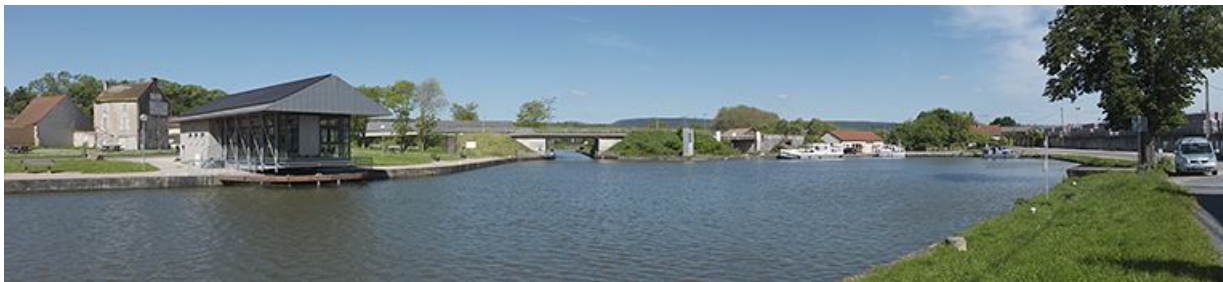
Vue d'ensemble du port avec au premier plan, la halte fluviale. Au centre, on peut apercevoir le pont-canal.
