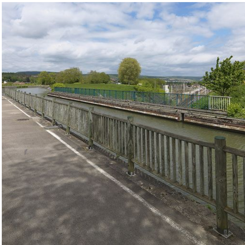
Vue d'ensemble du pont-canal avec la voie ferrée en dessous.
