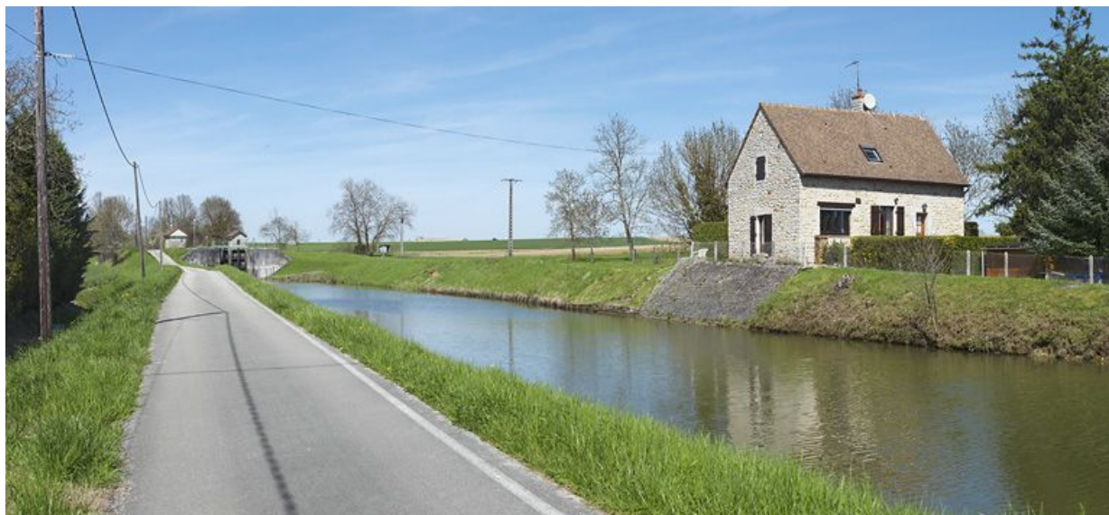
Vue d'ensemble avec à droite, la maison du site d'écluse XXXIV, en aval du site d'écluse 25 que l'on voit en arrière-plan. 71, Rully, lieudit : bief 26 du versant Saône-Méditerranée
