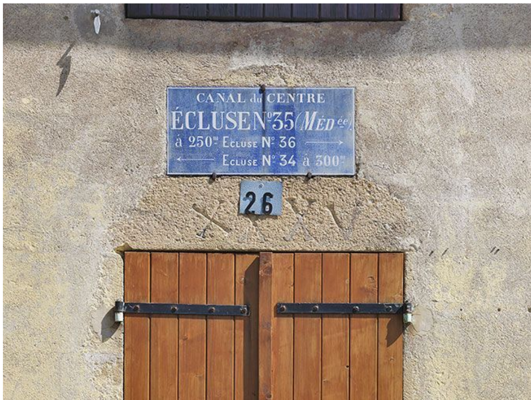
Détail de la plaque émaillée et de la gravure sur le linteau de la maison éclusière.
