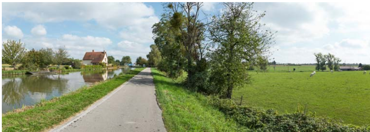
Vue d'ensemble du site d'écluse et du chemin de halage. 71, Fontaines, lieudit : bief 32 du versant Saône-Méditerranée
