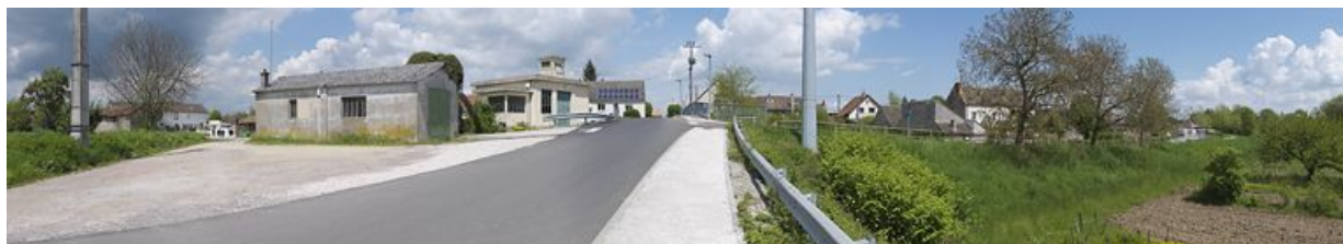
Vue d'ensemble du site : à gauche, le canal, au centre, la station de pompage et à droite, le port de Fragnes (IA71002192). 71, Fragnes, lieudit : bief 34 du versant Saône-Méditerranée
