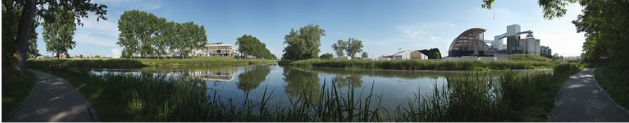
Vue d'ensemble de l'embranchement de Saint-Gobain, avec à droite les silos Sanders. Le canal est au centre. 71, Champforgeuil, lieudit : bief 34 bis du versant Saône-Méditerranée
