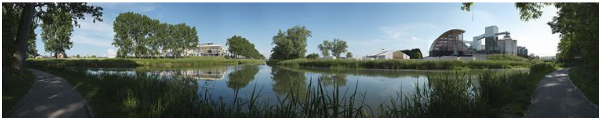
Vue d'ensemble de l'embranchement de Saint-Gobain, avec à droite les silos Sanders. Le canal est au centre. 71, Champforgeuil, lieudit : bief 34 bis du versant Saône-Méditerranée
