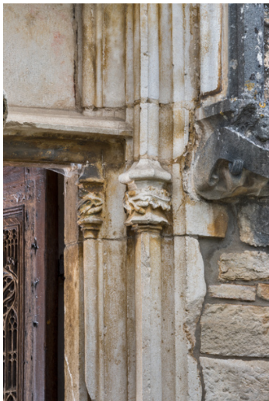
Piédroit, détail de la partie supérieure, droite.
