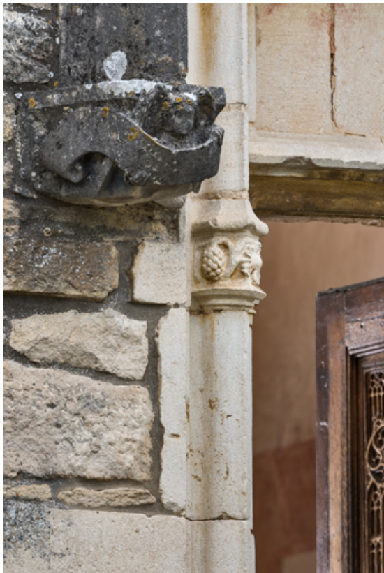
Piédroit, détail de la partie supérieure, gauche.
