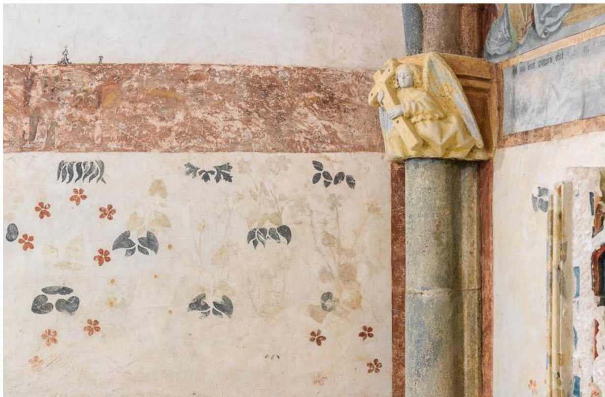
Détail des peintures murales du mur gauche, récemment restaurées.
