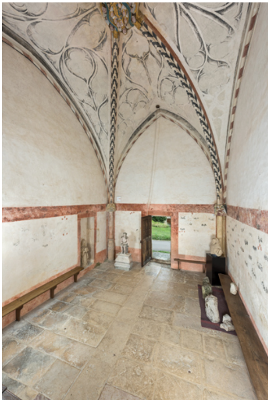
Vue d'ensemble de l'intérieur, en direction de l'entrée (porte ouverte).
