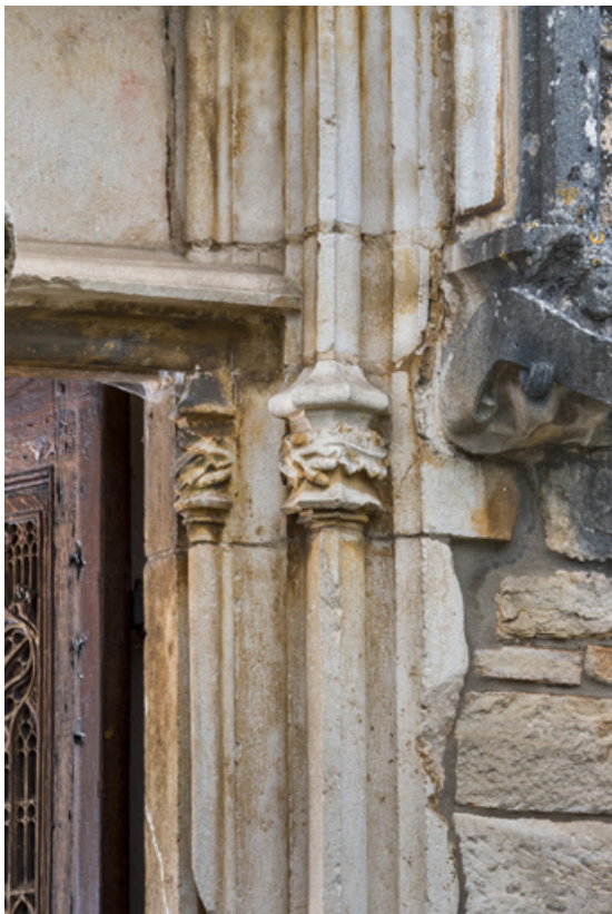
Piédroit, détail de la partie supérieure, droite.
