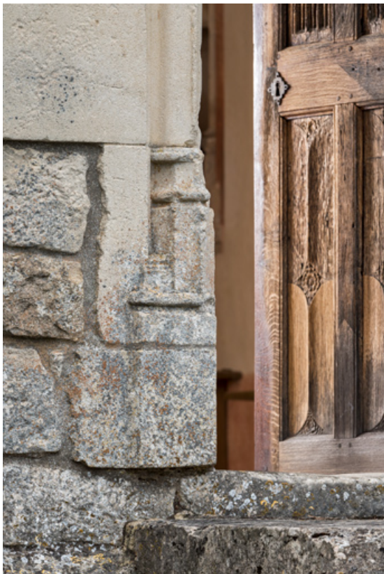
Piédroit, détail de la partie inférieure, gauche.
