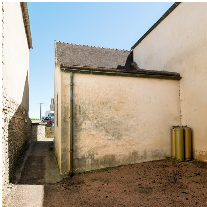
Chapelle de la dernière travée du bas-côté nord.
