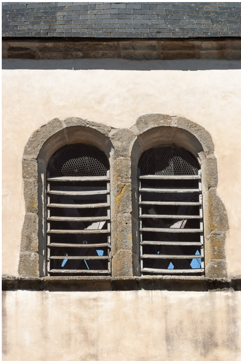
Clocher, détail de deux baies jumelées.
