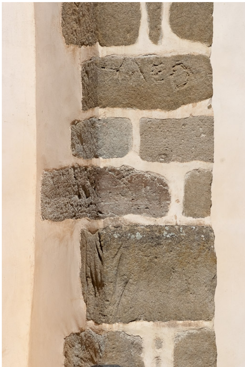
Contrefort de la nef, détail de marques dans la pierre.
