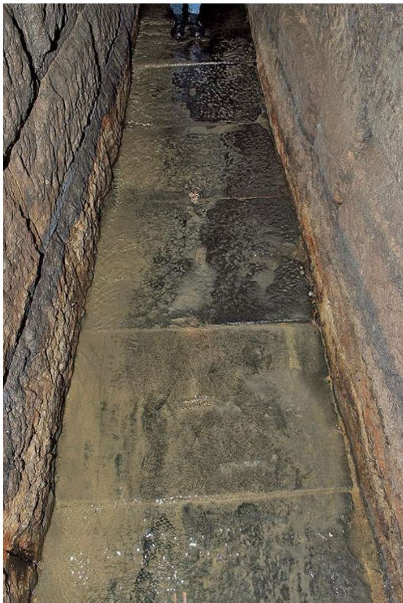
Deuxième galerie : détail des dalles du sol.
