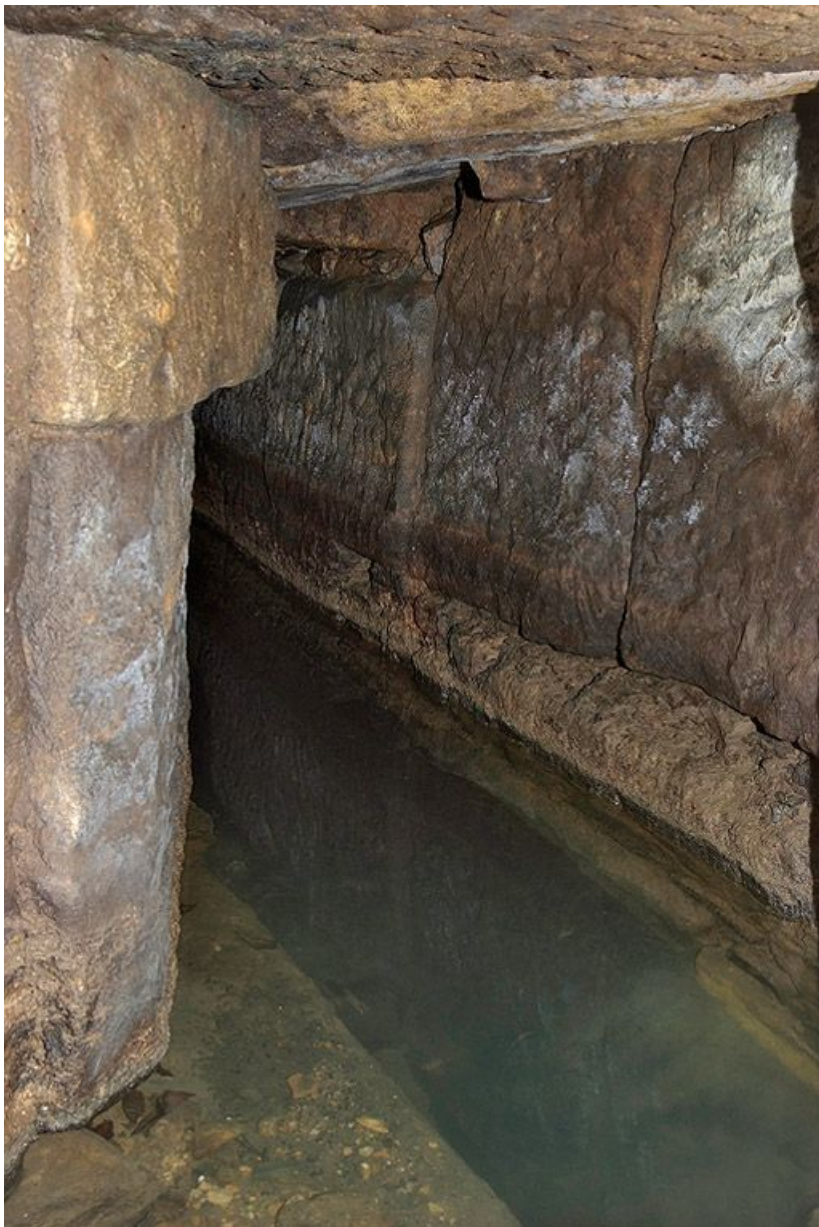
Première galerie : partie est.
