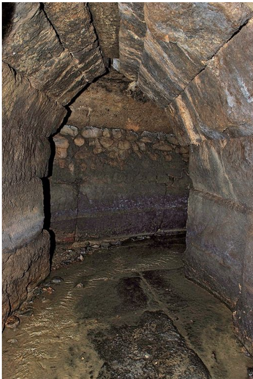
Section reliant les deux galeries.
