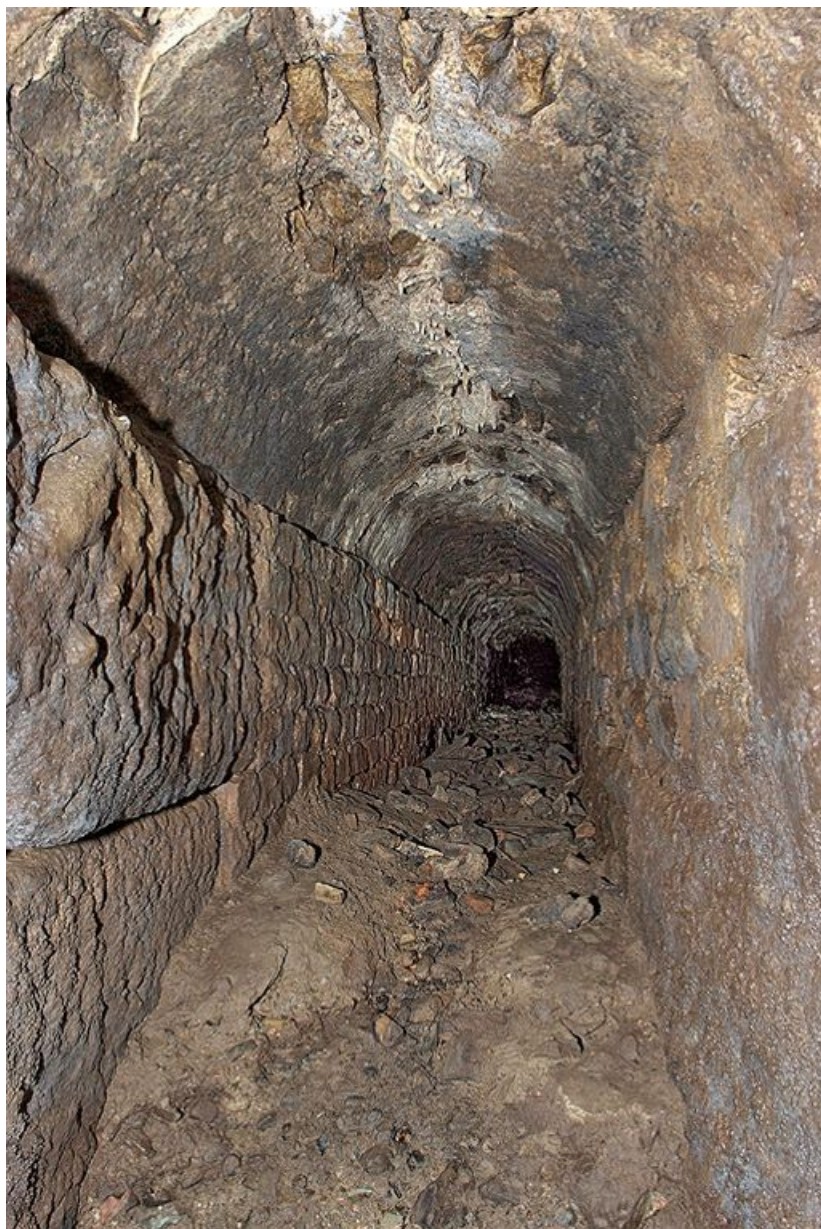
Première galerie : partie ouest partiellement obstruée par des gravats. 71, Bourbon-Lancy Parc Thermal
