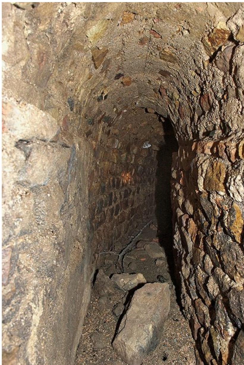
Partie en U de la deuxième galerie : embranchement gauche. 71, Bourbon-Lancy Parc Thermal
