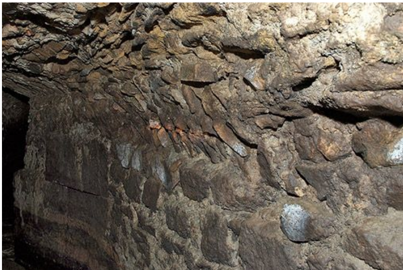
Partie en U de la deuxième galerie : détail.
