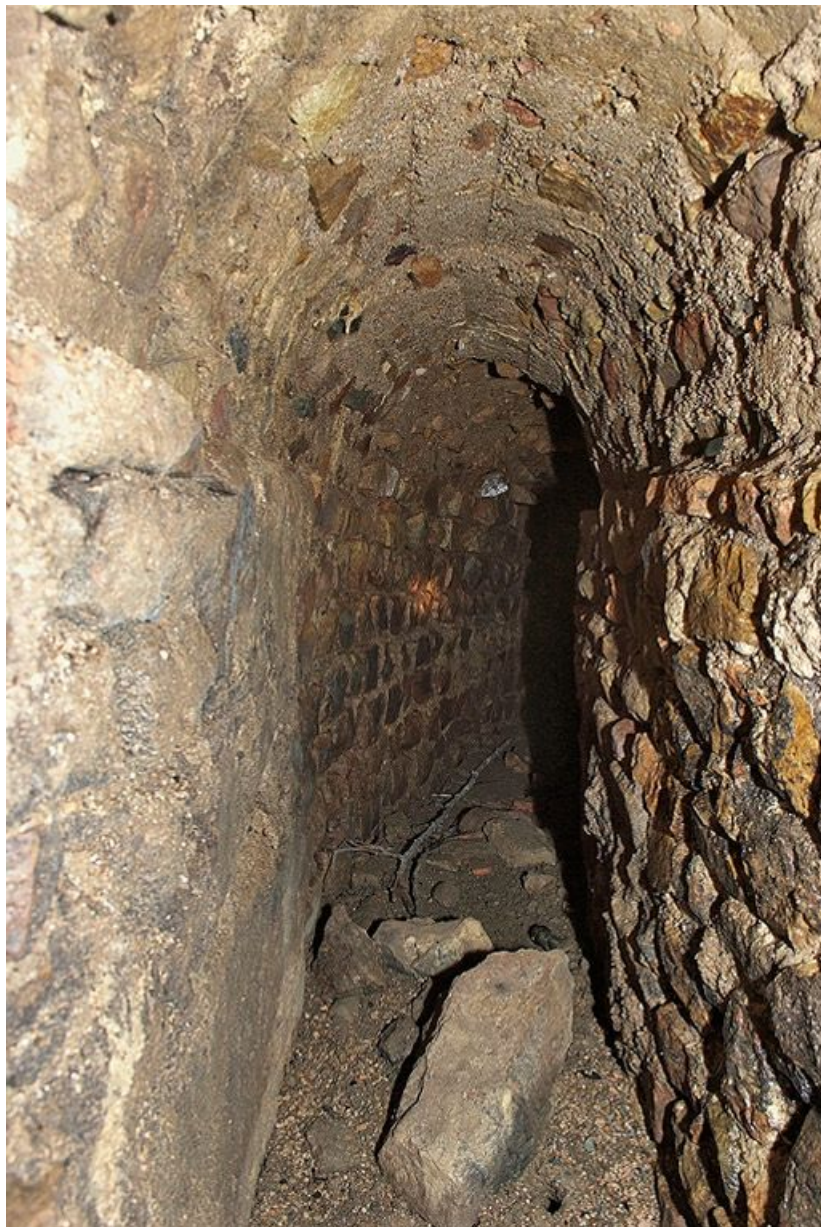
Partie en U de la deuxième galerie : embranchement gauche. 71, Bourbon-Lancy Parc Thermal
