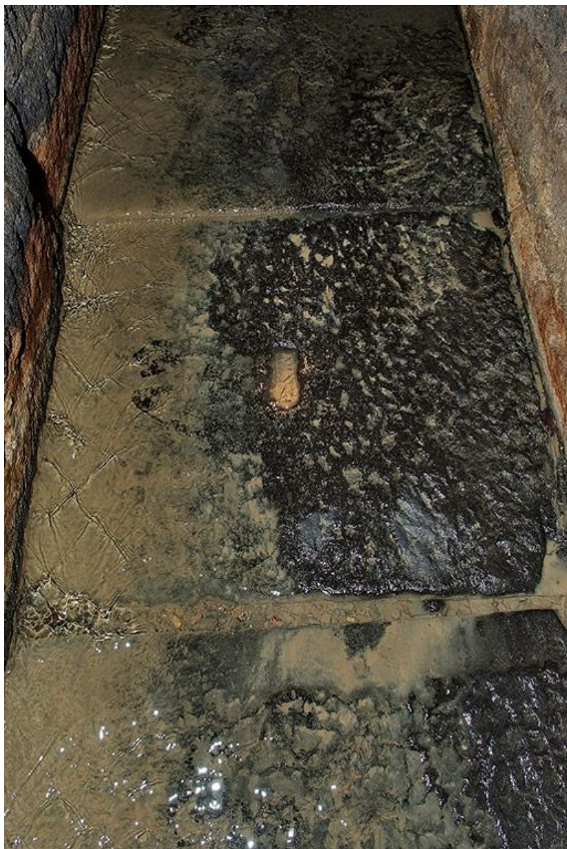
Deuxième galerie : détail des dalles du sol.
