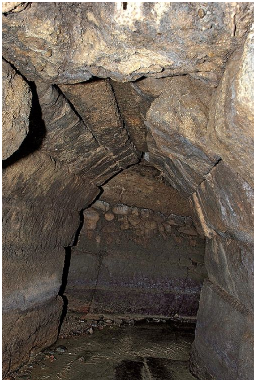
Section reliant les deux galeries.
