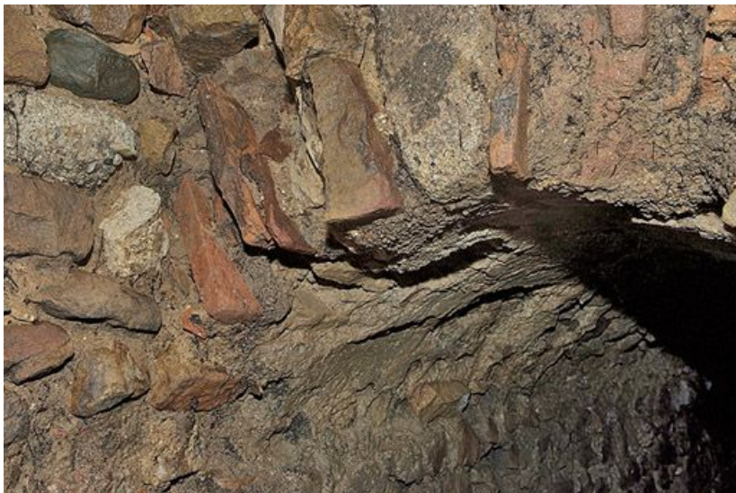
Partie en U de la deuxième galerie : détail de la voûte.
