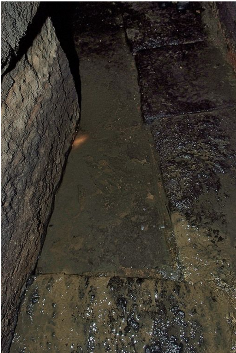
Angle de la section intermédiaire avec la deuxième galerie.
