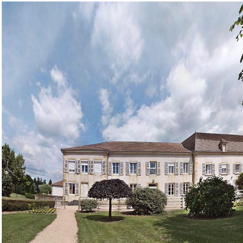
Bâtiment donnant rue de la Gare, corps gauche.
