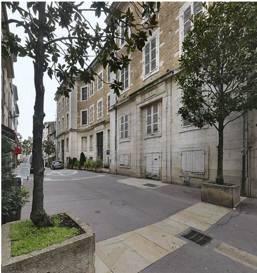
Vue de la façade principale rue Carnot.
