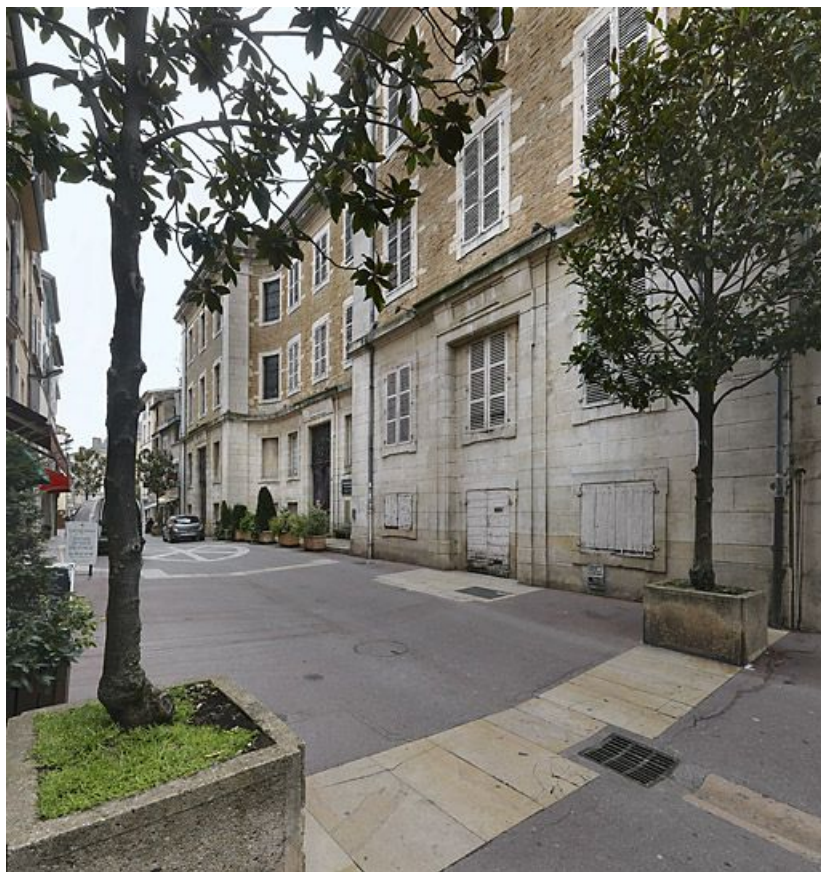
Vue de la façade principale rue Carnot.
