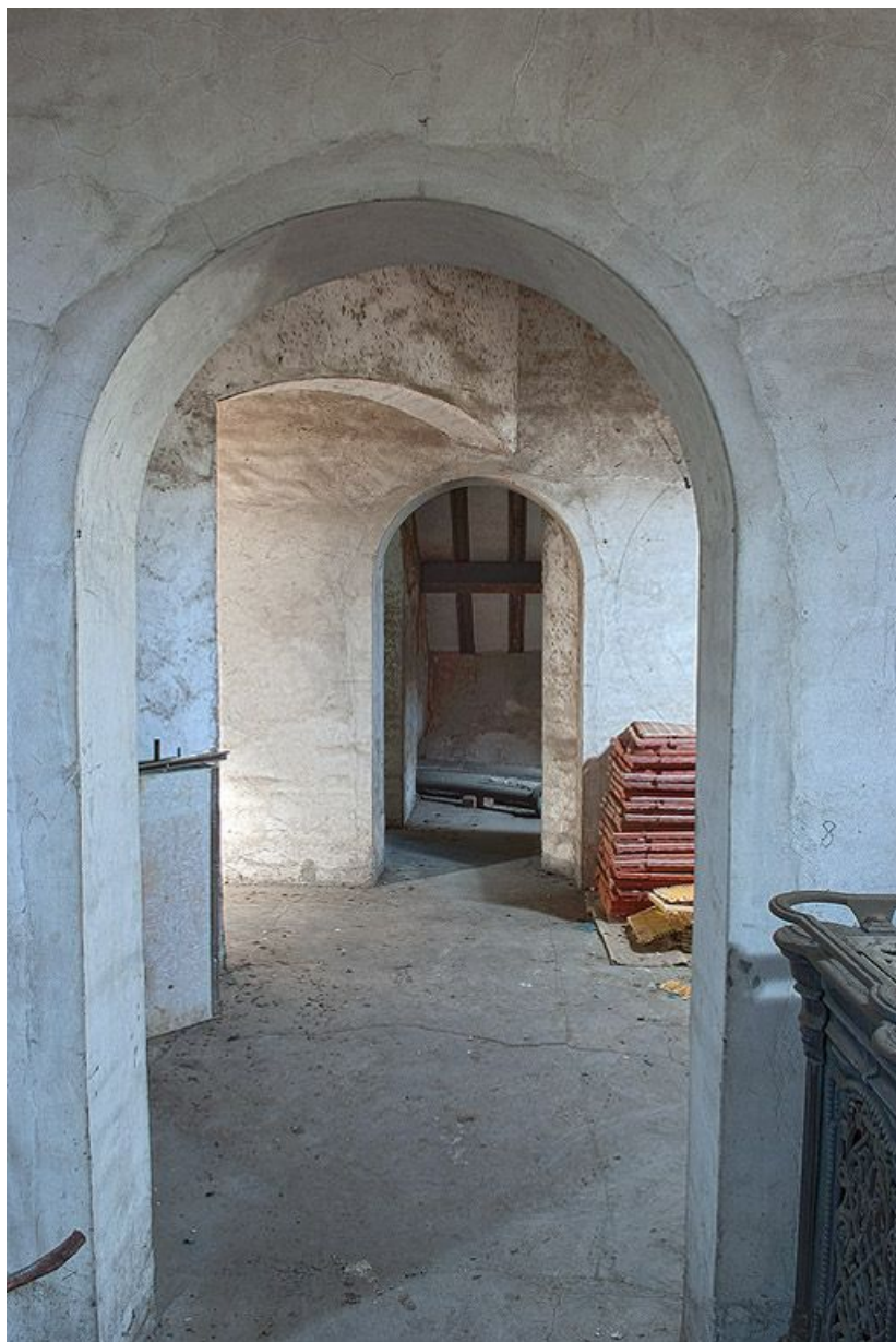
Comble : partie gauche du corps central.
