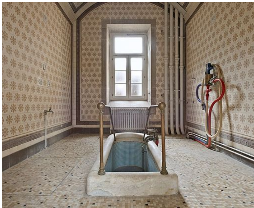
Salle de bain de l'angle de l'aile droite et du corps central.
