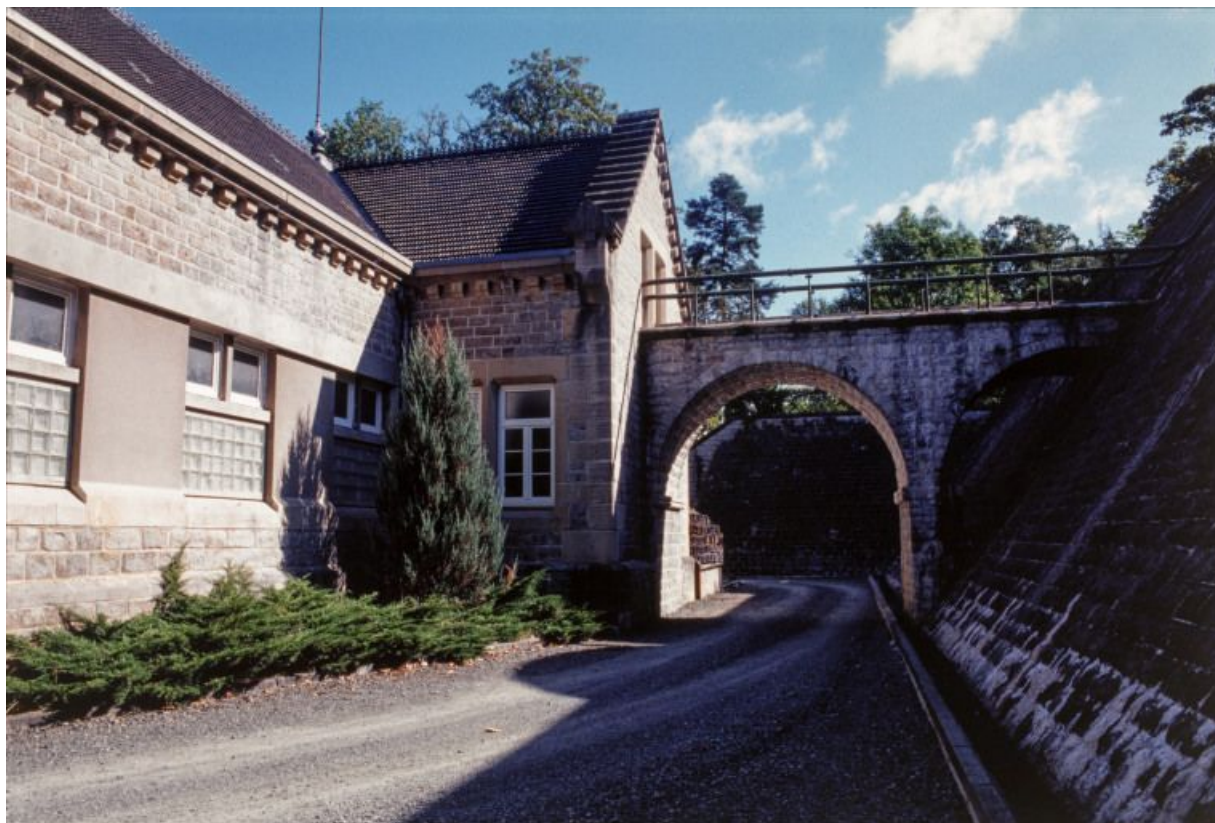
Élévation postérieure et pont-aqueduc. 71, Bourbon-Lancy rue de la Chaumière
