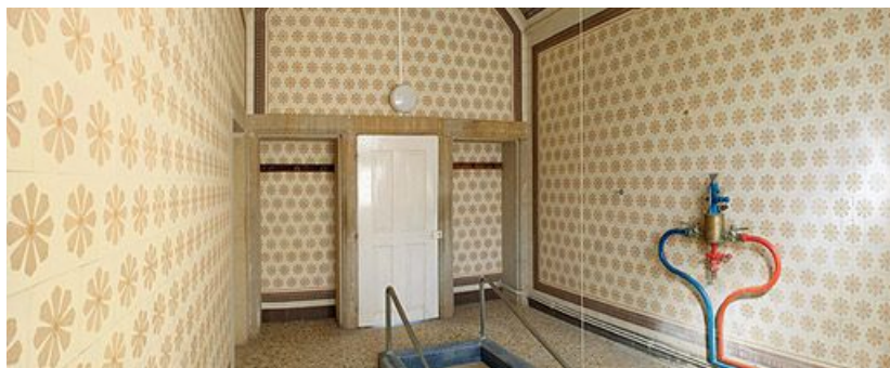
Corps central, salle de bain à droite du couloir du cabinet du médecin, vue vers la porte. 71, Bourbon-Lancy rue de la Chaumière
