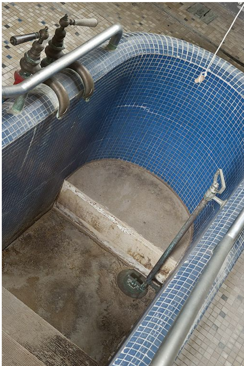
Corps central, salle de bain à droite du couloir du cabinet du médecin : détail de la baignoire. 71, Bourbon-Lancy rue de la Chaumière
