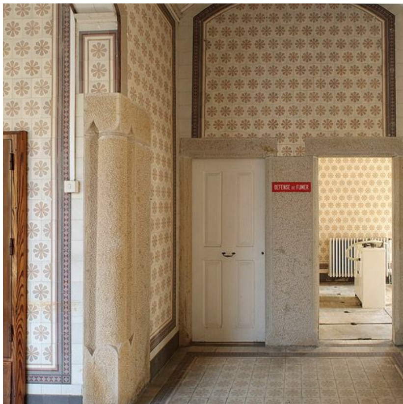
Extrémité gauche de la galerie du corps central.
