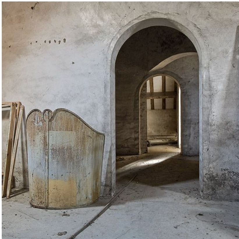
Comble : partie droite du corps central. 71, Bourbon-Lancy rue de la Chaumière
