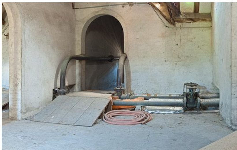
Comble : porte menant à l'aqueduc. 71, Bourbon-Lancy rue de la Chaumière
