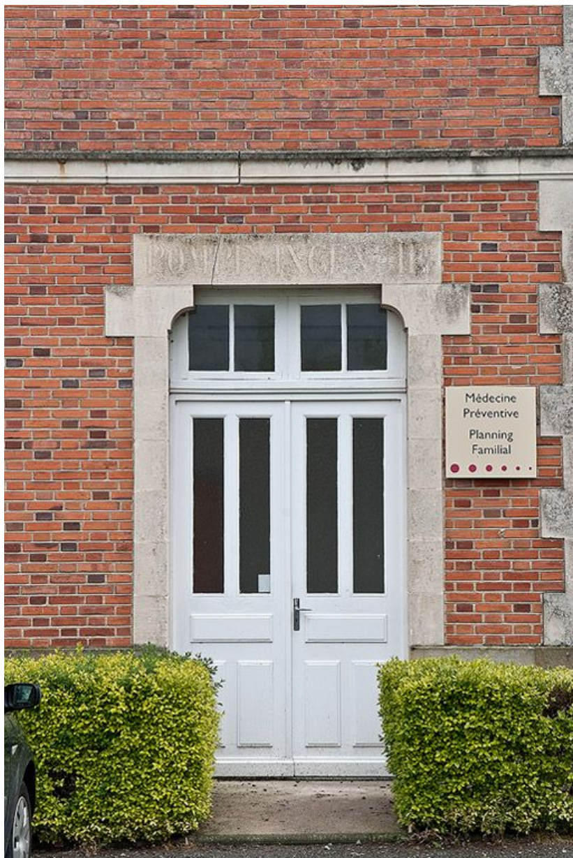
Bâtiment de services : porte latérale. 71, Bourbon-Lancy rue de la Chaumière
