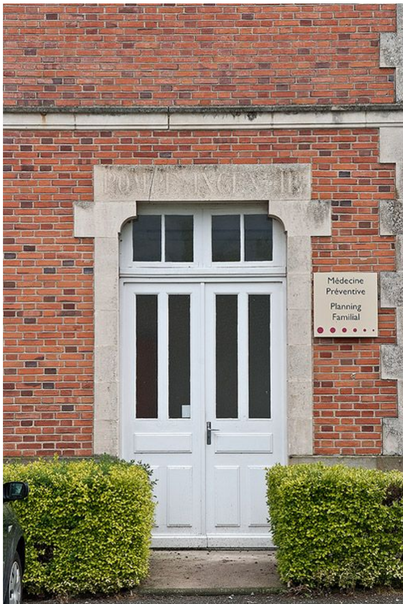
Bâtiment de services : porte latérale.
