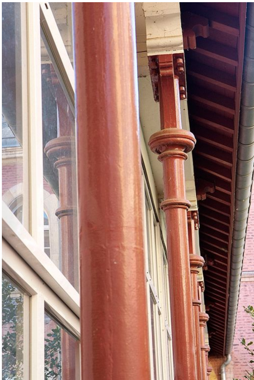
Colonnettes en fonte de la galerie derrière l'église.
