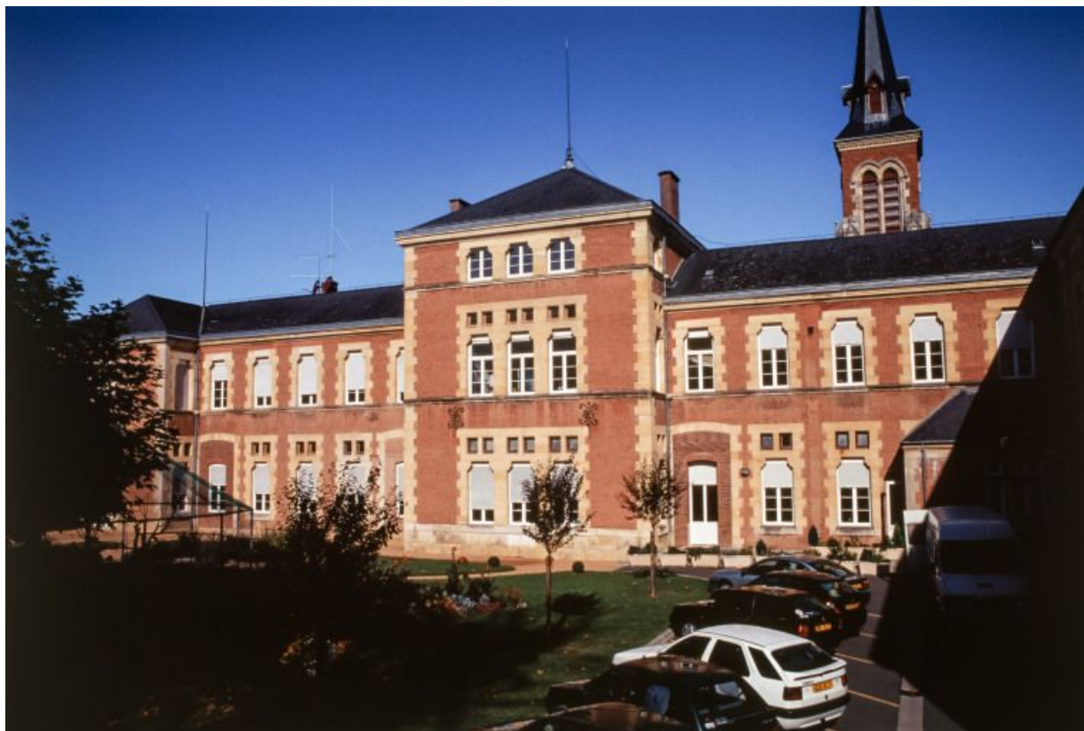
Façade postérieure de l'aile droite.
