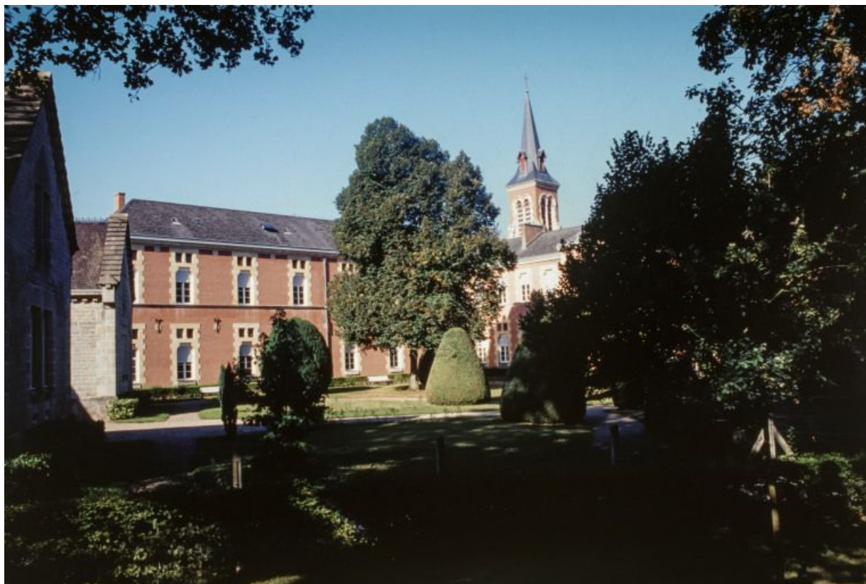
Bâtiment en retour sur la façade postérieure de l'aile gauche.
