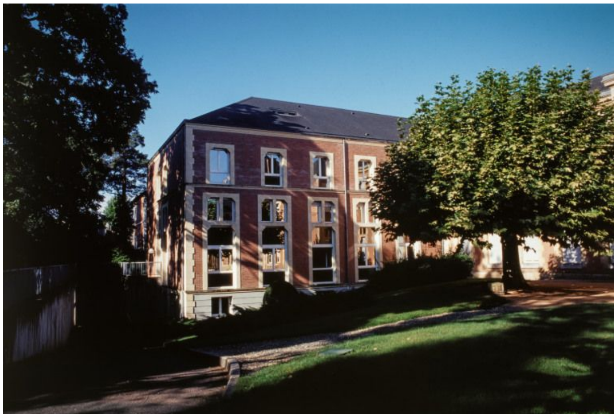
Façade postérieure, partie gauche.
