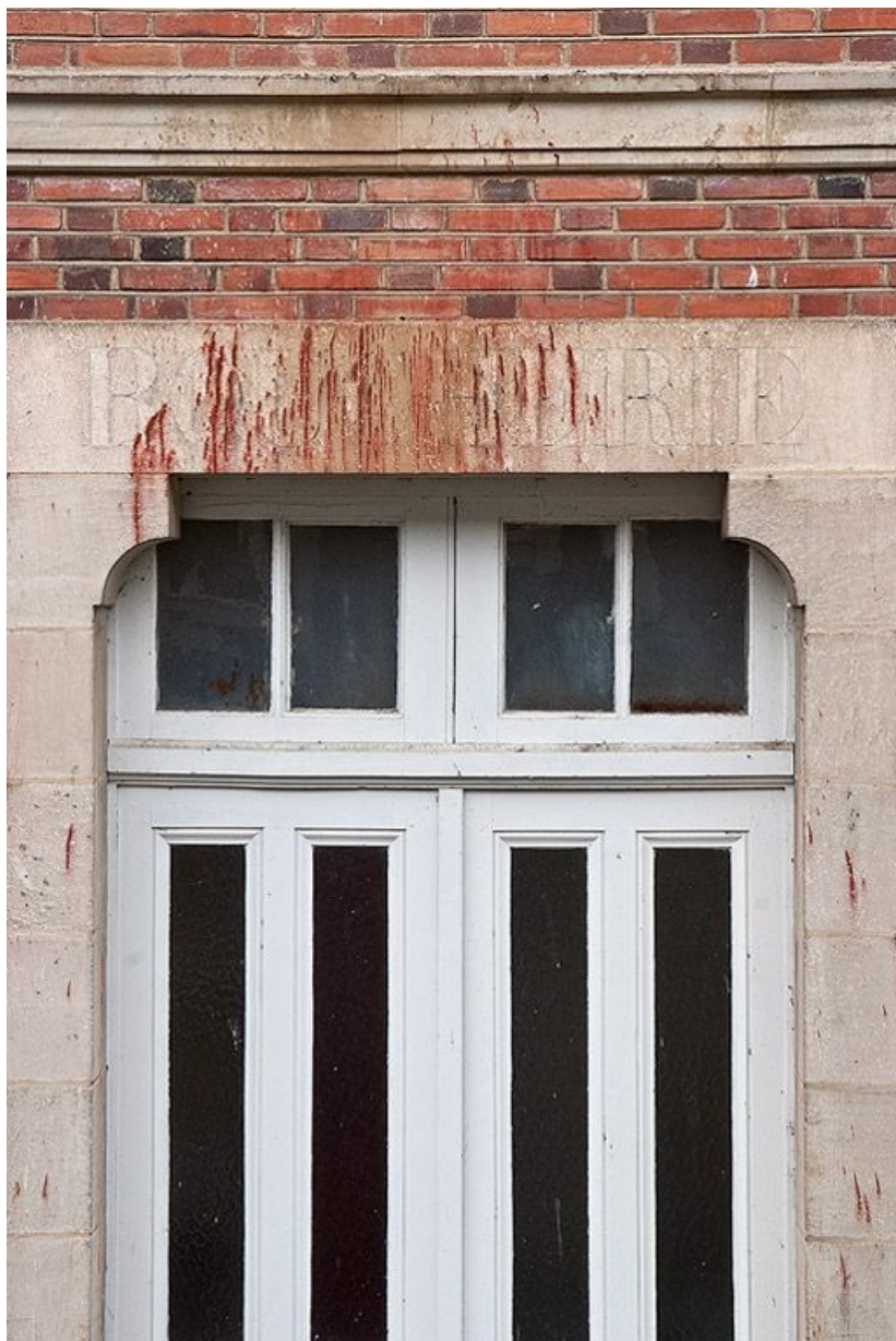
Bâtiment de services : détail.
