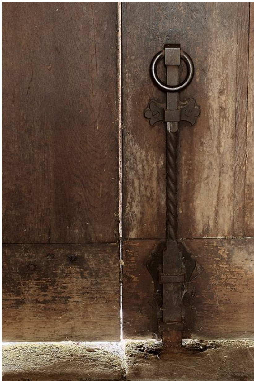
Chapelle : détail de la porte.
