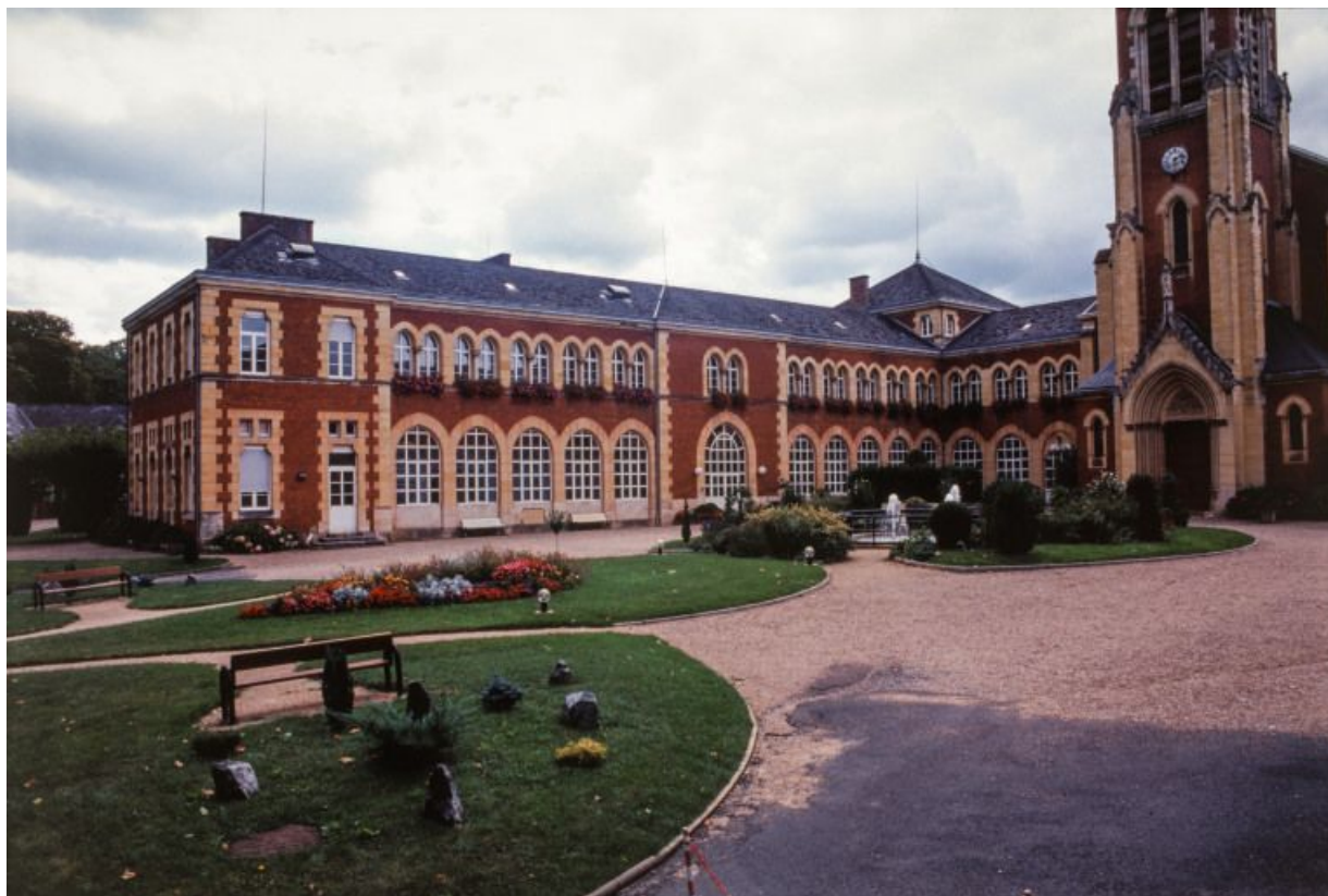
Aile gauche, façade antérieure.
