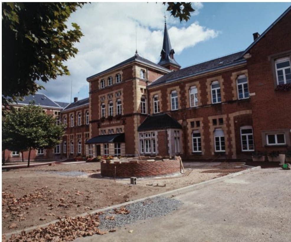
Façade postérieure de l'aile droite.
