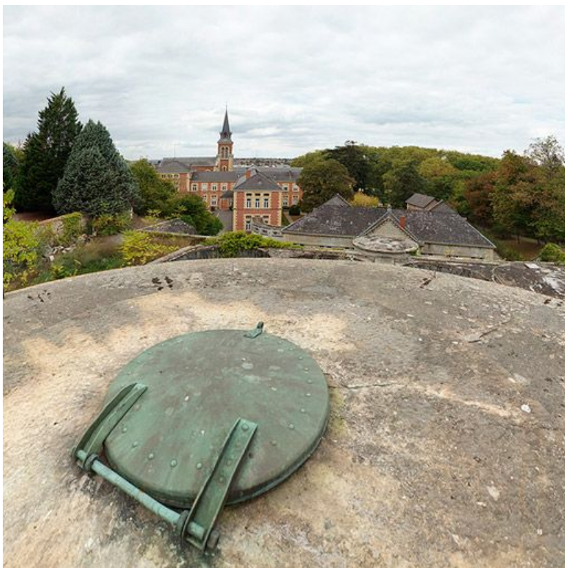
Vue d'ensemble de l'hôpital avec le trou d'homme du château d'eau au premier plan. 71, Bourbon-Lancy Aligre
