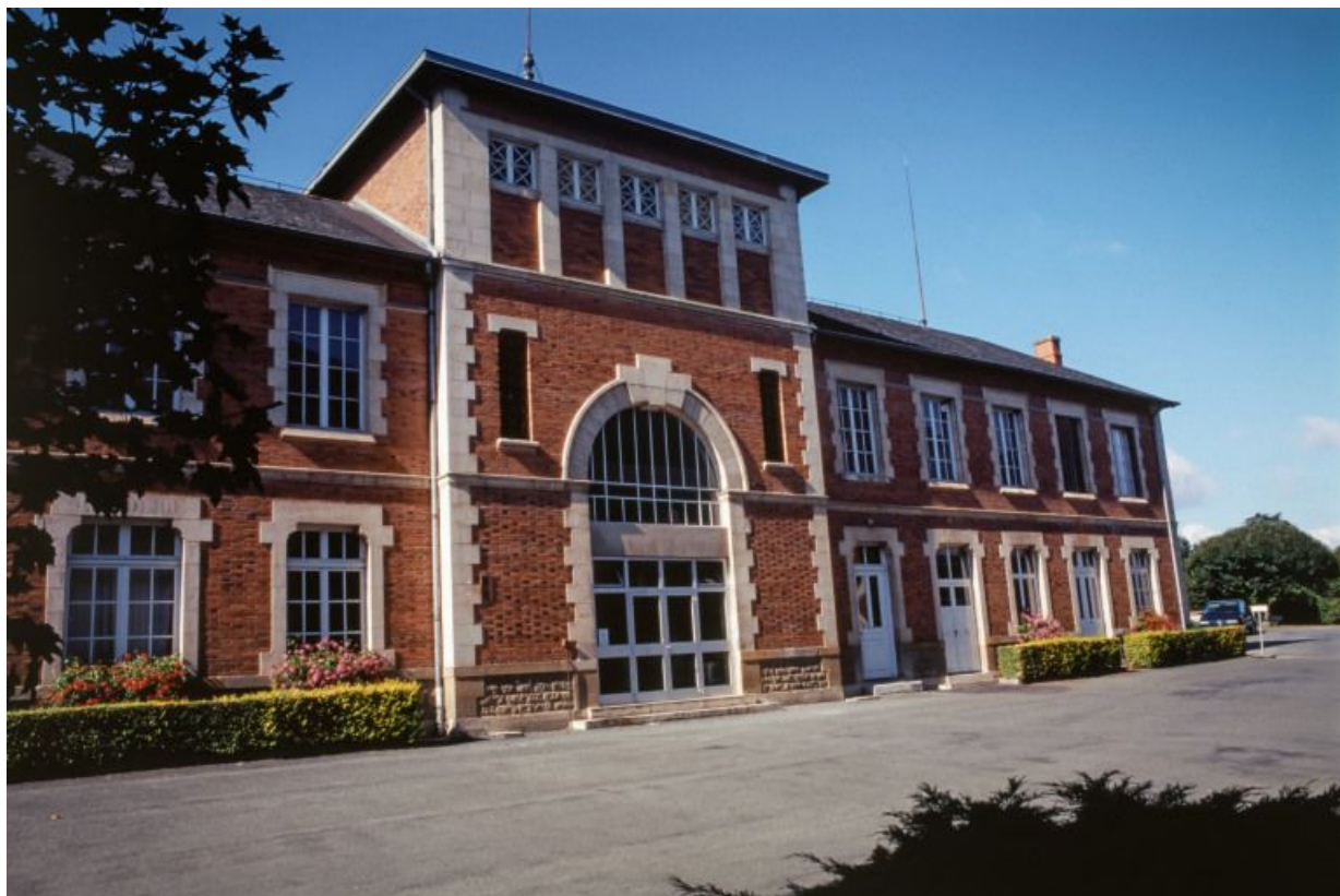
Bâtiment de service, façade antérieure. 71, Bourbon-Lancy Aligre
