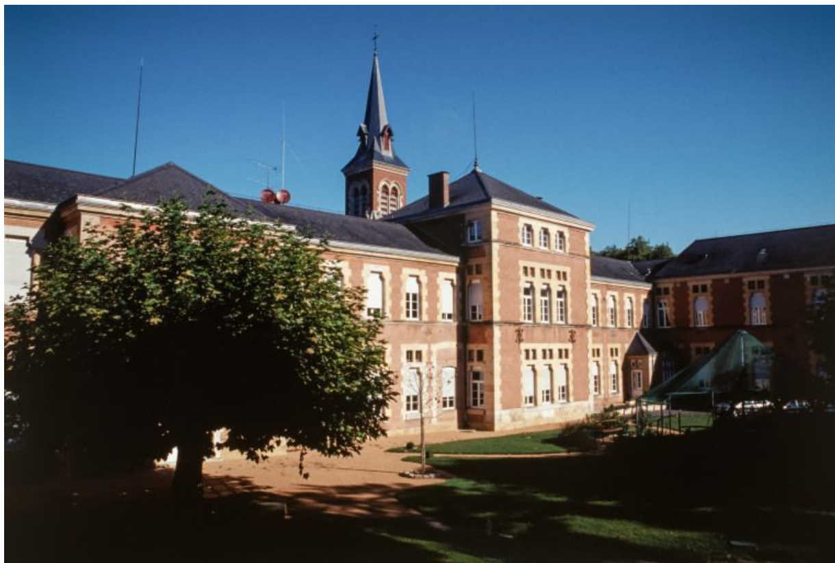
Façade postérieure de l'aile droite.
