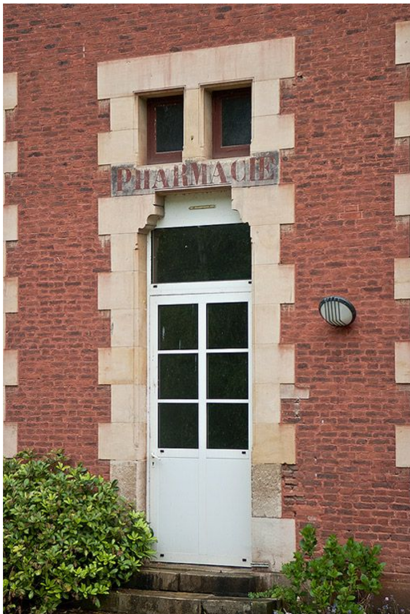
Pavillon de l'aile gauche : porte de l'ancienne pharmacie. 71, Bourbon-Lancy rue de la Chaumière
