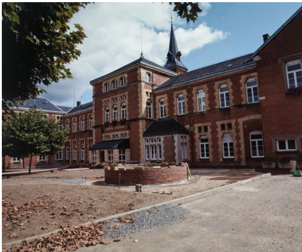
Façade postérieure de l'aile droite.
