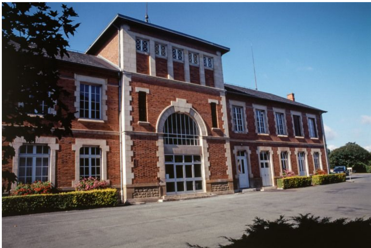
Bâtiment de service, façade antérieure. 71, Bourbon-Lancy Aligre
