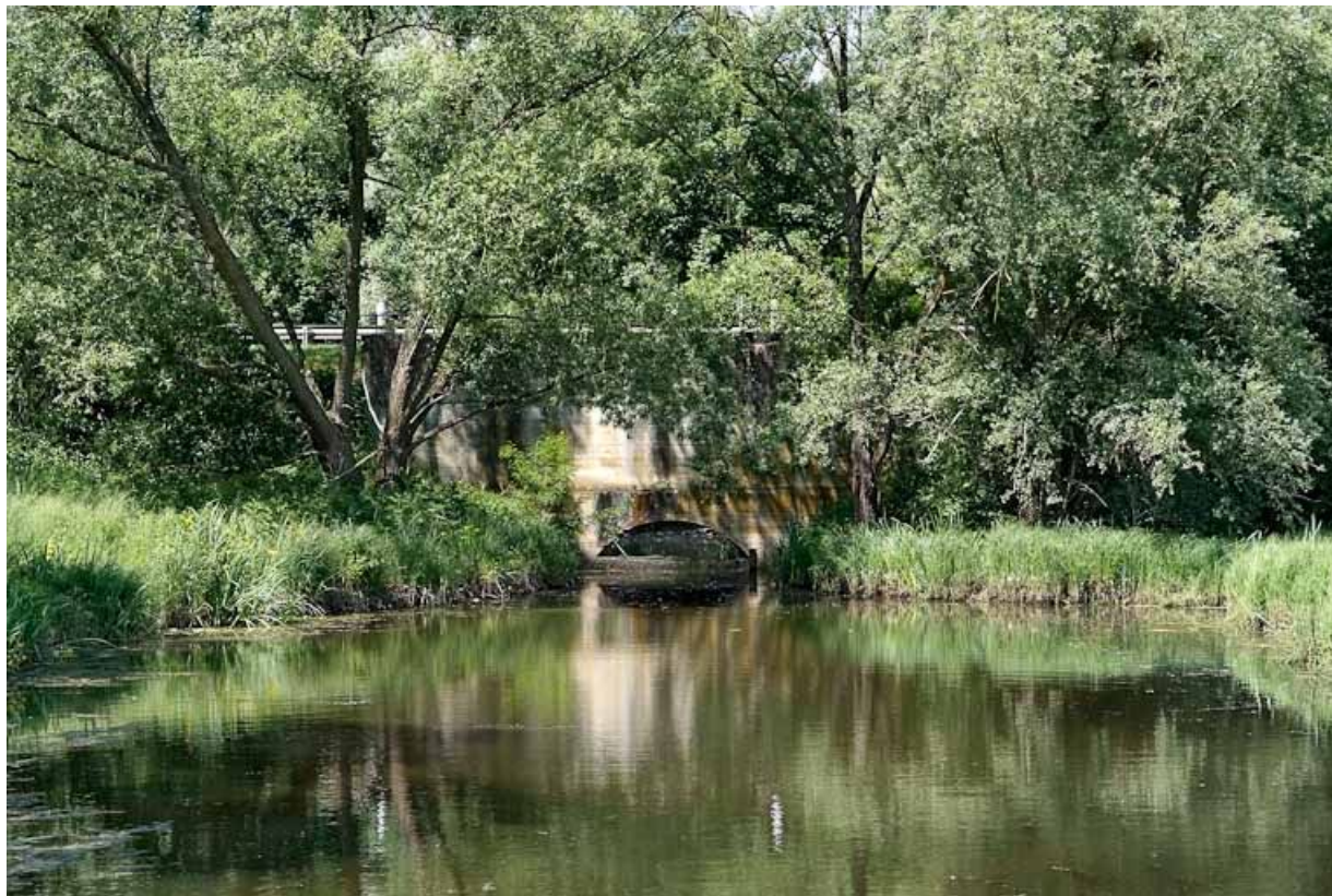
Pont sous la RD 971, Seille au premier plan, vue rapprochée. 71, Louhans
