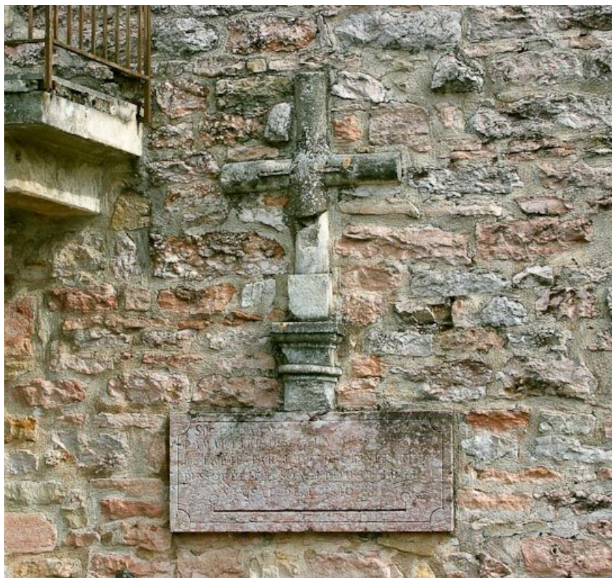
Maison située sur la rive droite de la Seille, sur le pignon : détail de la croix commémorative de la crue de la Seille de 1841. 71, Louhans
