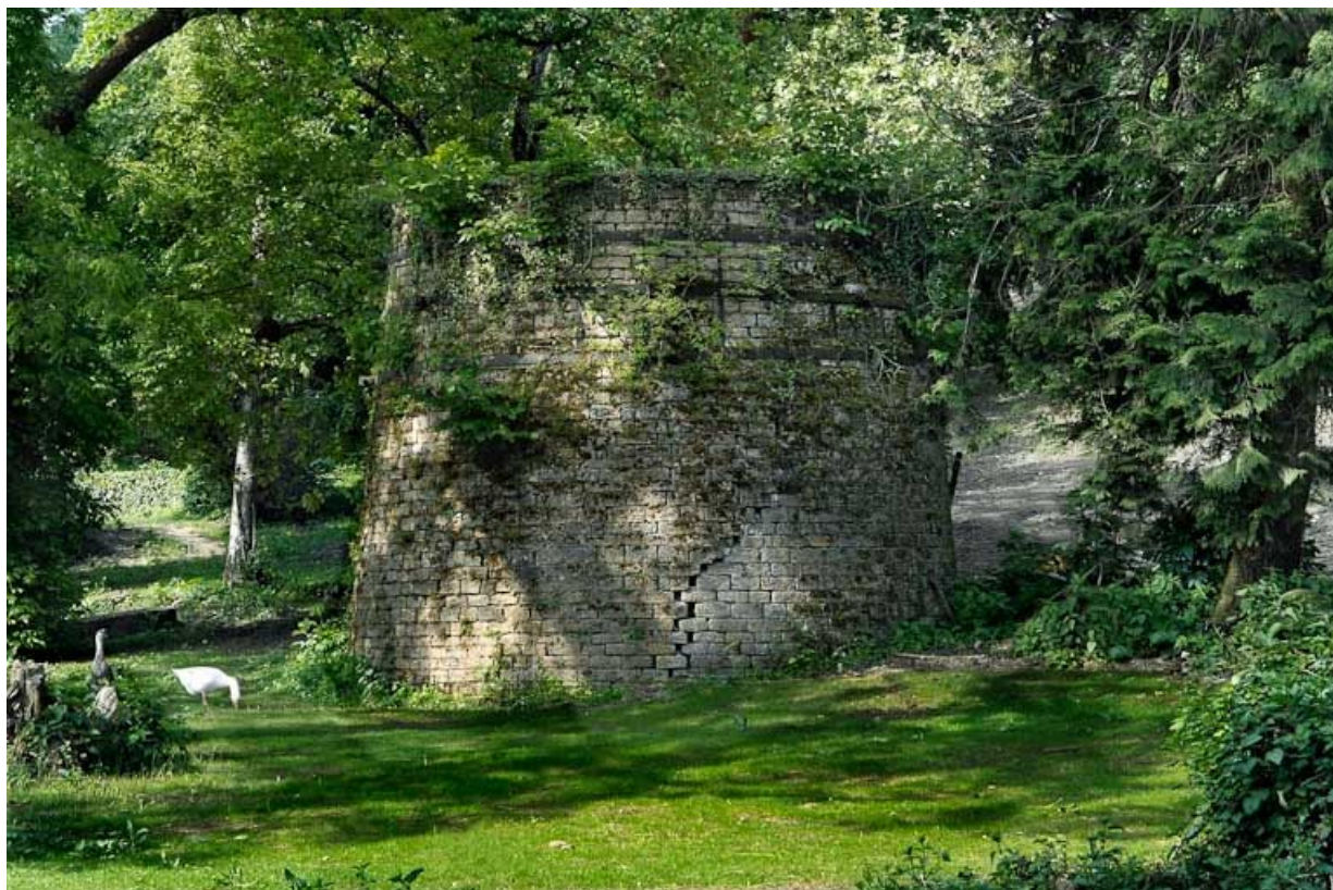
Tuilerie située avant le moulin : restes de la cheminée.
