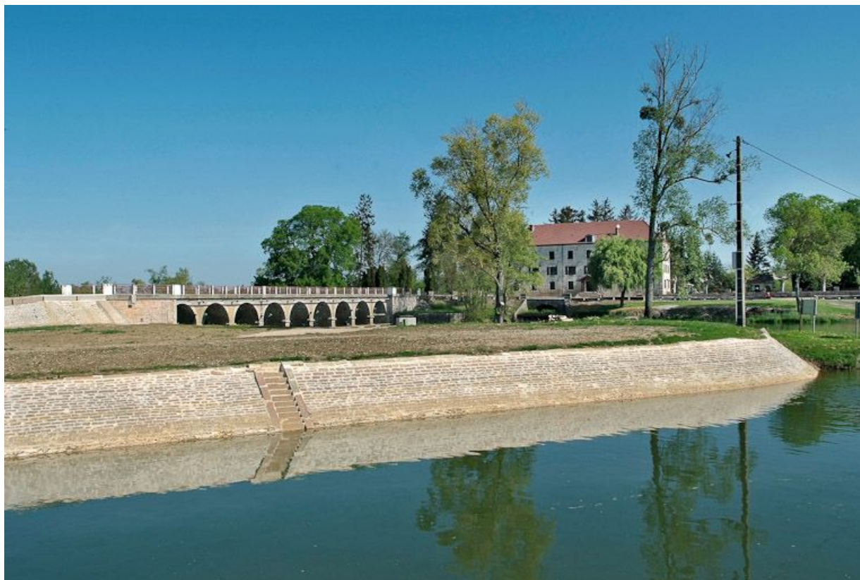
Barrage et pont de La Truchère à gauche, moulin à droite, au fond. Au premier plan : perré de l'écluse de La Truchère. 71, Louhans
