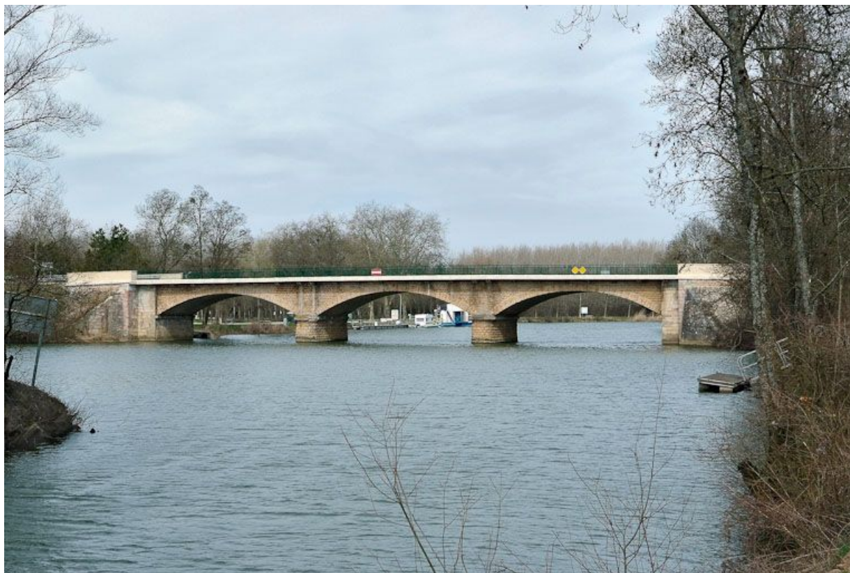
Le pont de Cuisery, vue d'amont.
