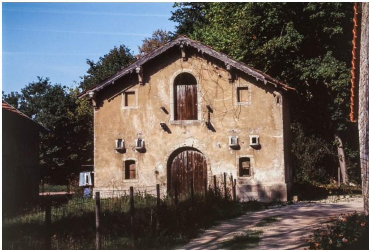
Maison du docteur Pailloux : dépendances avec pigeonnier. 71, Saint-Ambreuil Square
