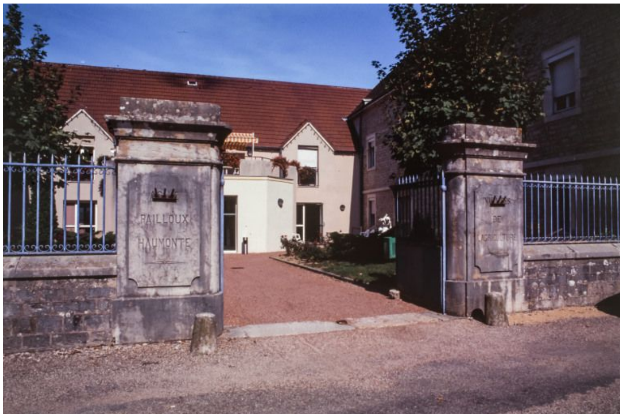
Ancien asile Pailloux-Haumonté, vue d'ensemble du portail d'entrée. 71, Saint-Ambreuil Square
