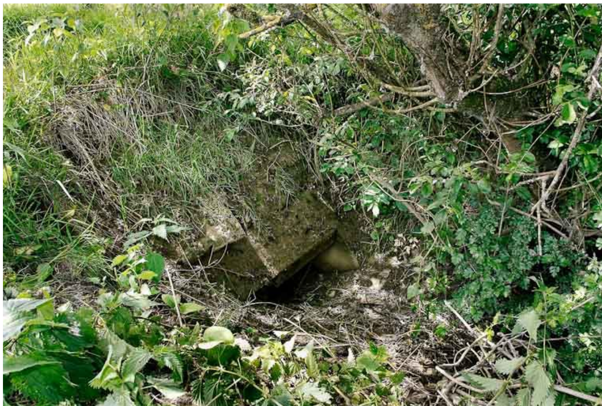
Un reste de ponceau ou d'aqueduc.
