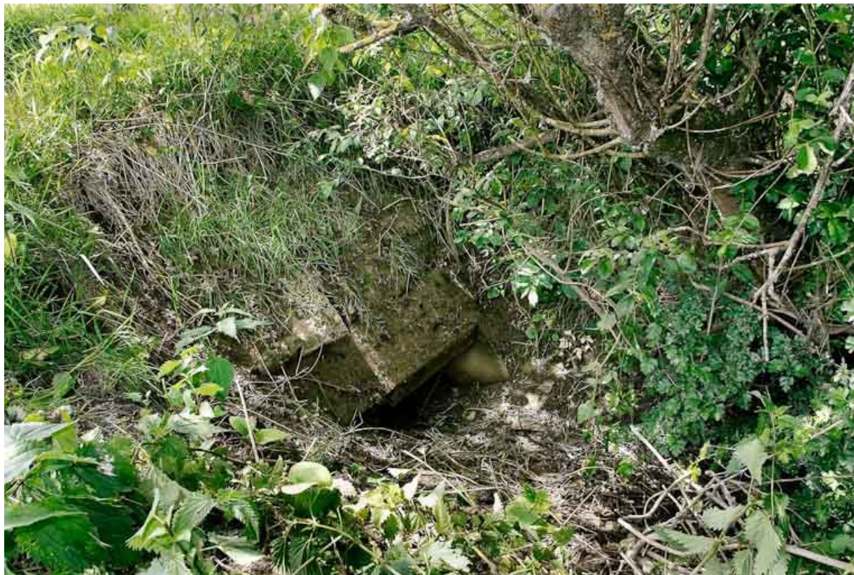
Un reste de ponceau ou d'aqueduc.
