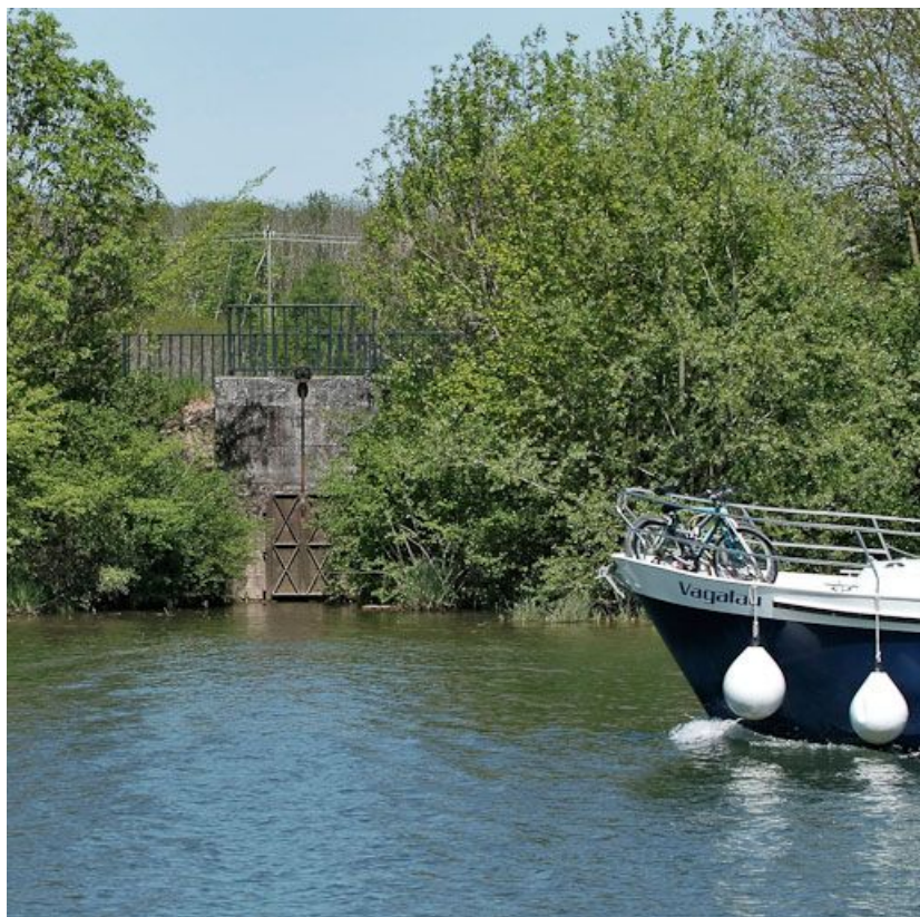
Vanne de l'aqueduc, Seille au premier plan.
