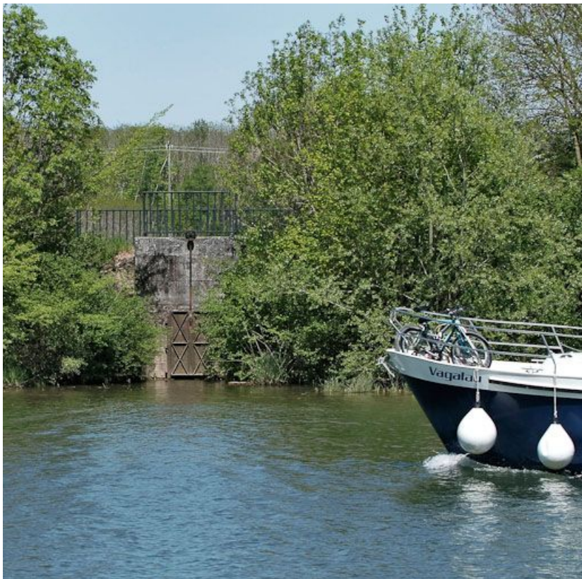
Vanne de l'aqueduc, Seille au premier plan.
