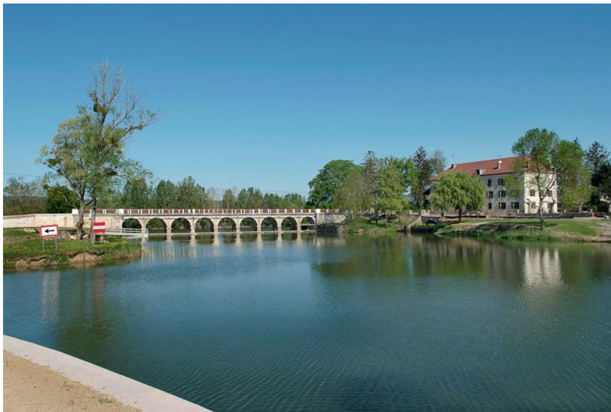
Barrage et pont de La Truchère à gauche, moulin à droite, vus de la rive gauche de la Seille.
