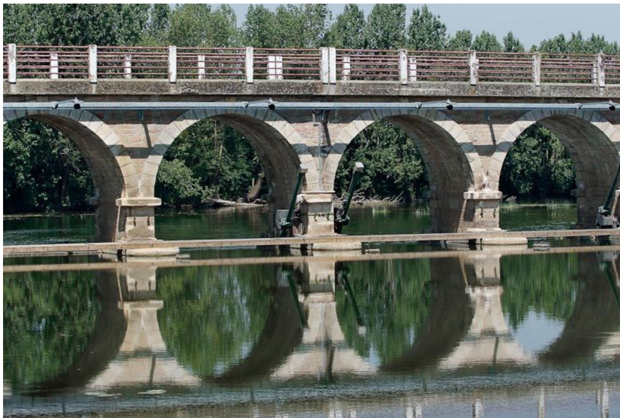
Barrage et du pont de La Truchère : détails de plusieurs arches.
