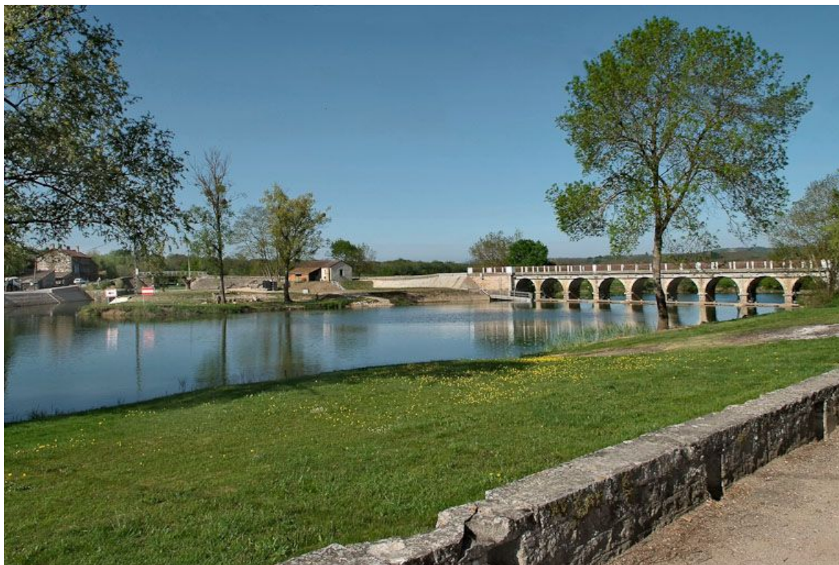
Barrage et pont de La Truchère à gauche, vus de la rive droite de la Seille. Complètement à gauche, écluse de La Truchère. 71, La Truchère, lieudit : la Tuilerie
