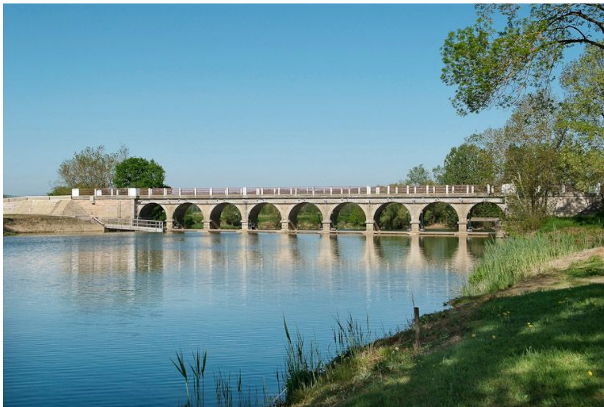
Barrage et pont de La Truchère, vus de la rive droite de la Seille.
