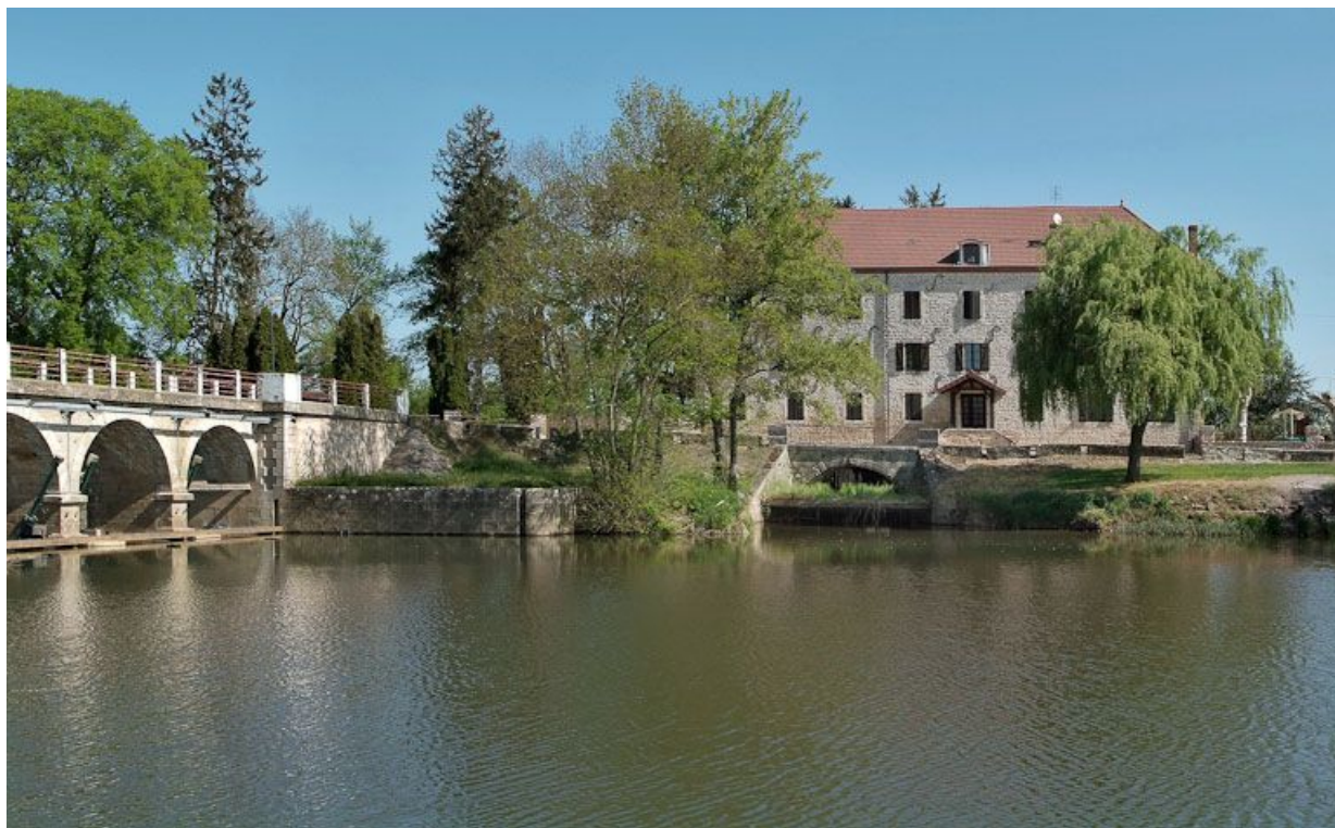
Barrage et pont de La Truchère à gauche, moulin à droite, vus de la rive droite de la Seille. 71, La Truchère, lieudit : la Tuilerie
