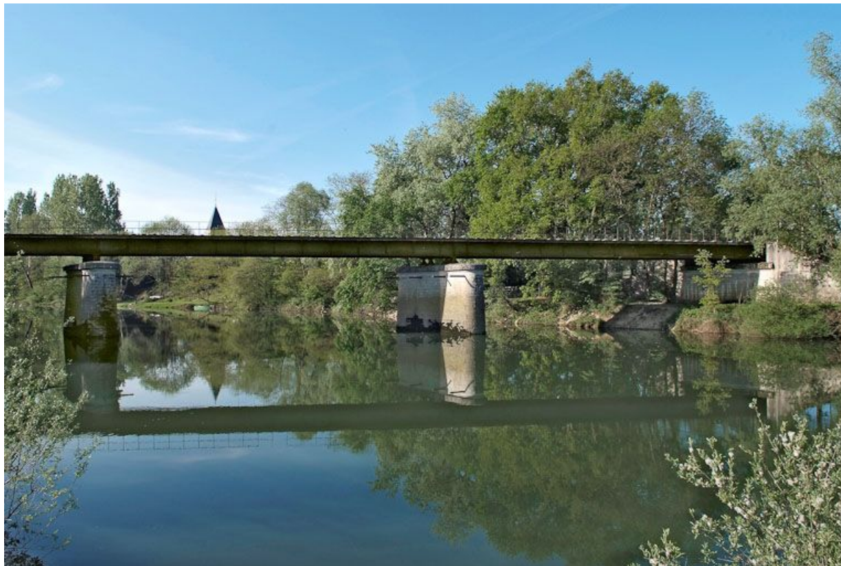
Pont de chemin de fer désaffecté, vue d'ensemble.
