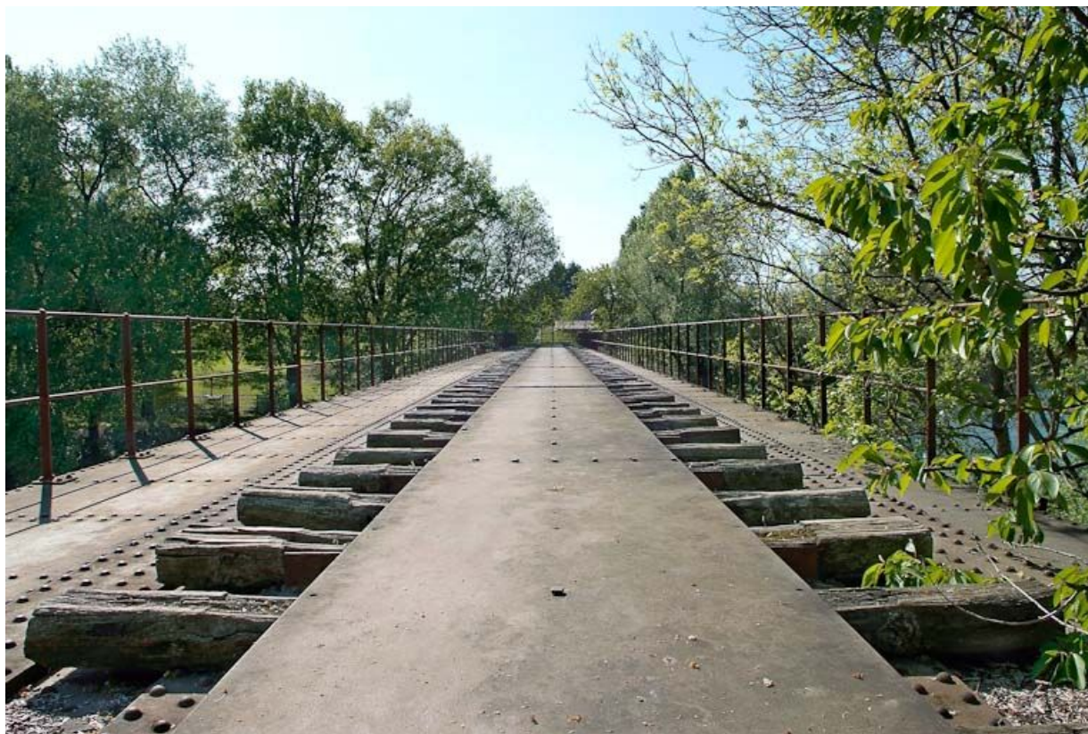
Pont de chemin de fer désaffecté : vue du platelage.
