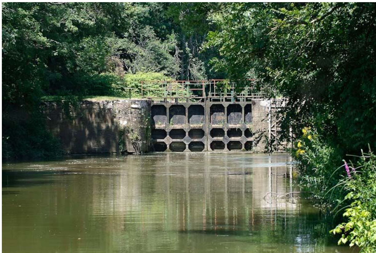
Le sas de l'écluse, vu d'aval.
