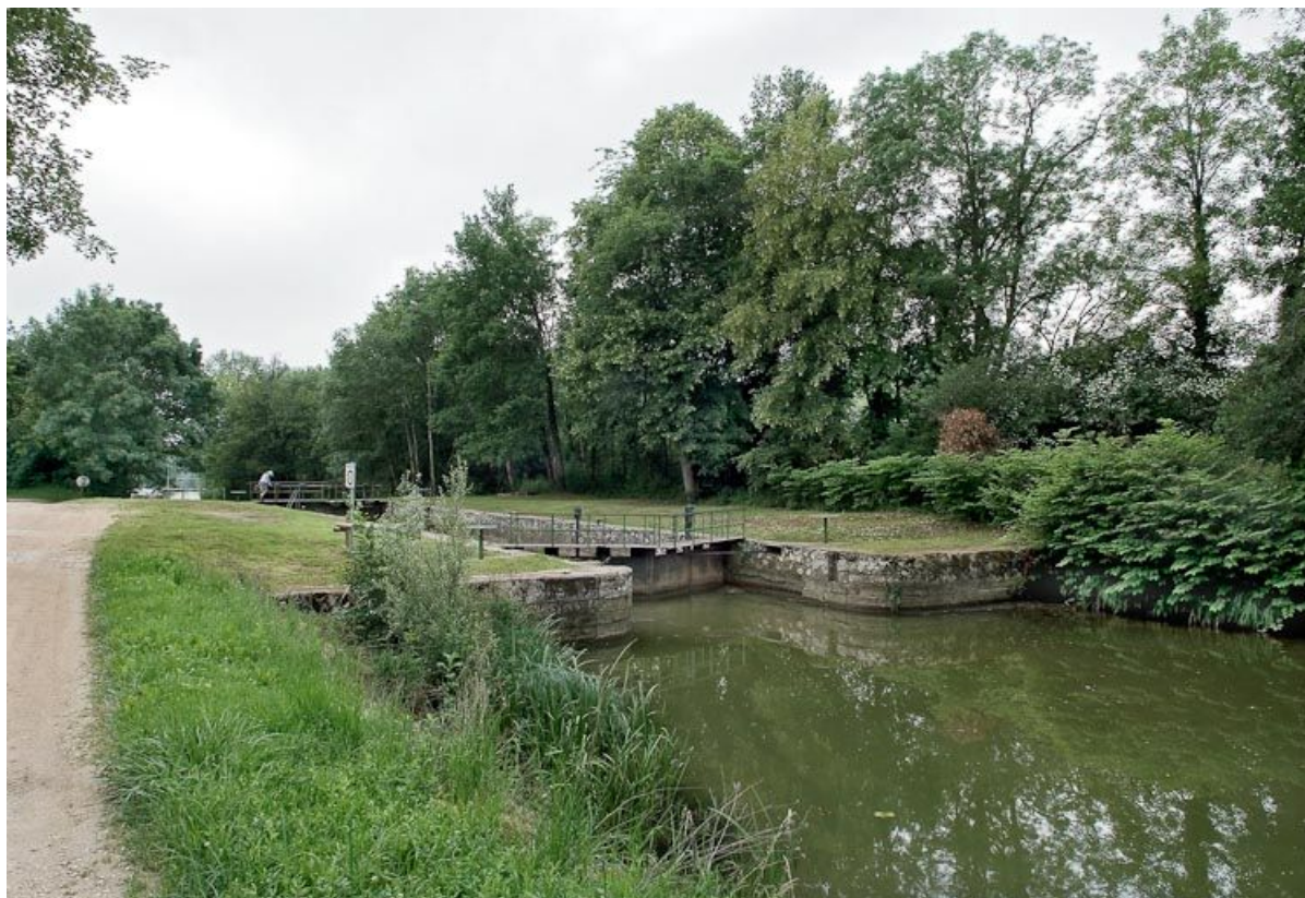
Le sas de l'écluse, avec l'emplacement de la maison éclésièrre à gauche. Vue d'amont.
