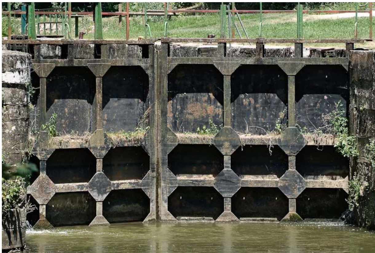
Le sas de l'écluse, vue rapprochée d'aval. Détail des vantaux.
