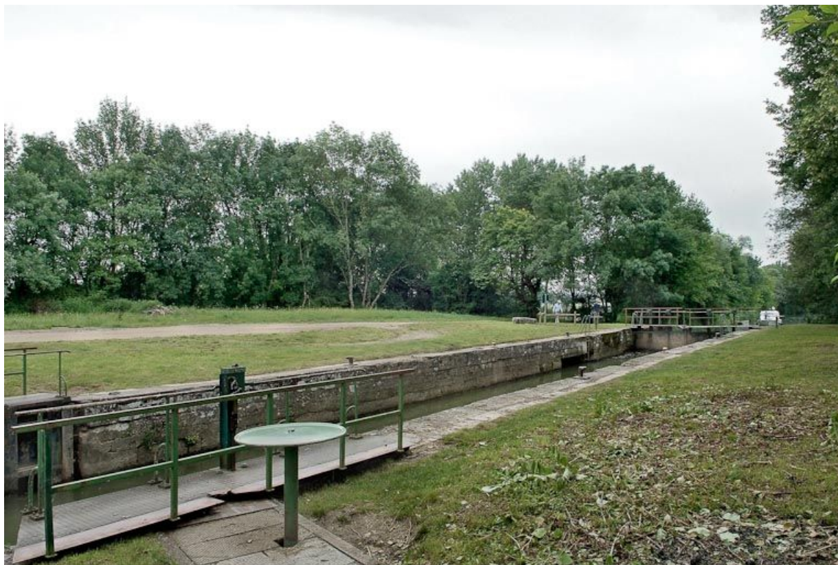
Le sas de l'écluse, avec l'emplacement de la maison éclusière détruite.
