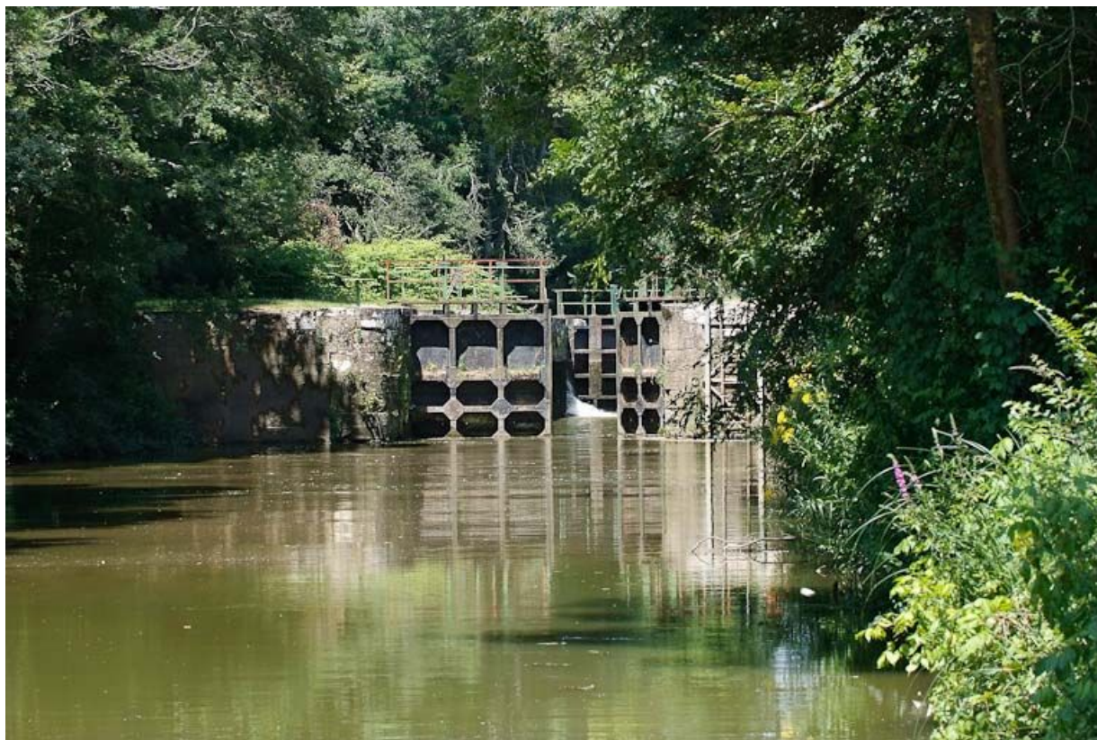
Le sas de l'écluse, vu d'aval.
