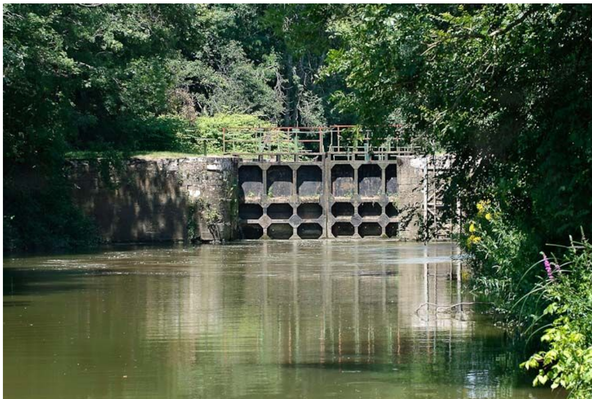
Le sas de l'écluse, vu d'aval.
