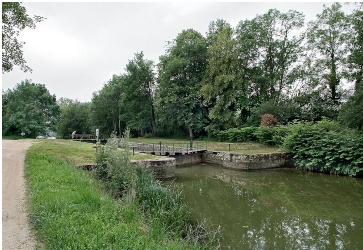
Le sas de l'écluse, avec l'emplacement de la maison éclusière à gauche. Vue d'amont.
