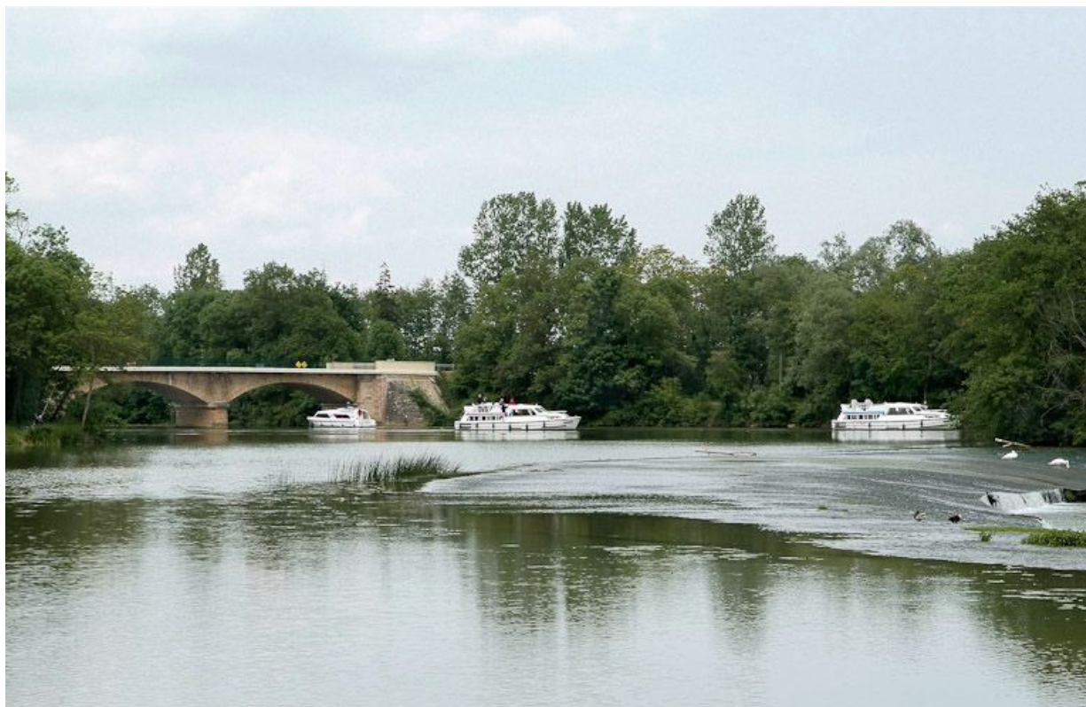
Le pont de Cuisery, vu d'aval.
