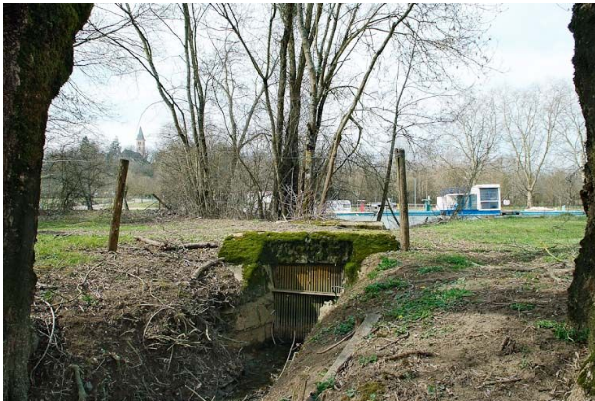
Aqueduc de la Rampe, avec la Seille en fond.
