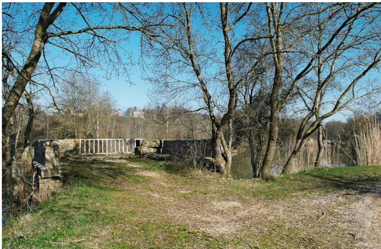
Arrivée sur la pile de l'ancien pont à bascule, vue du chemin de halage.
