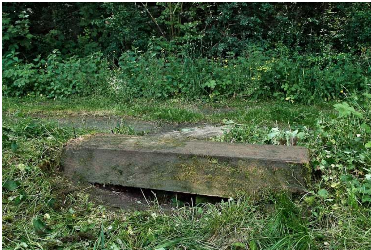
Linteau restant du pont des Freteurs.
