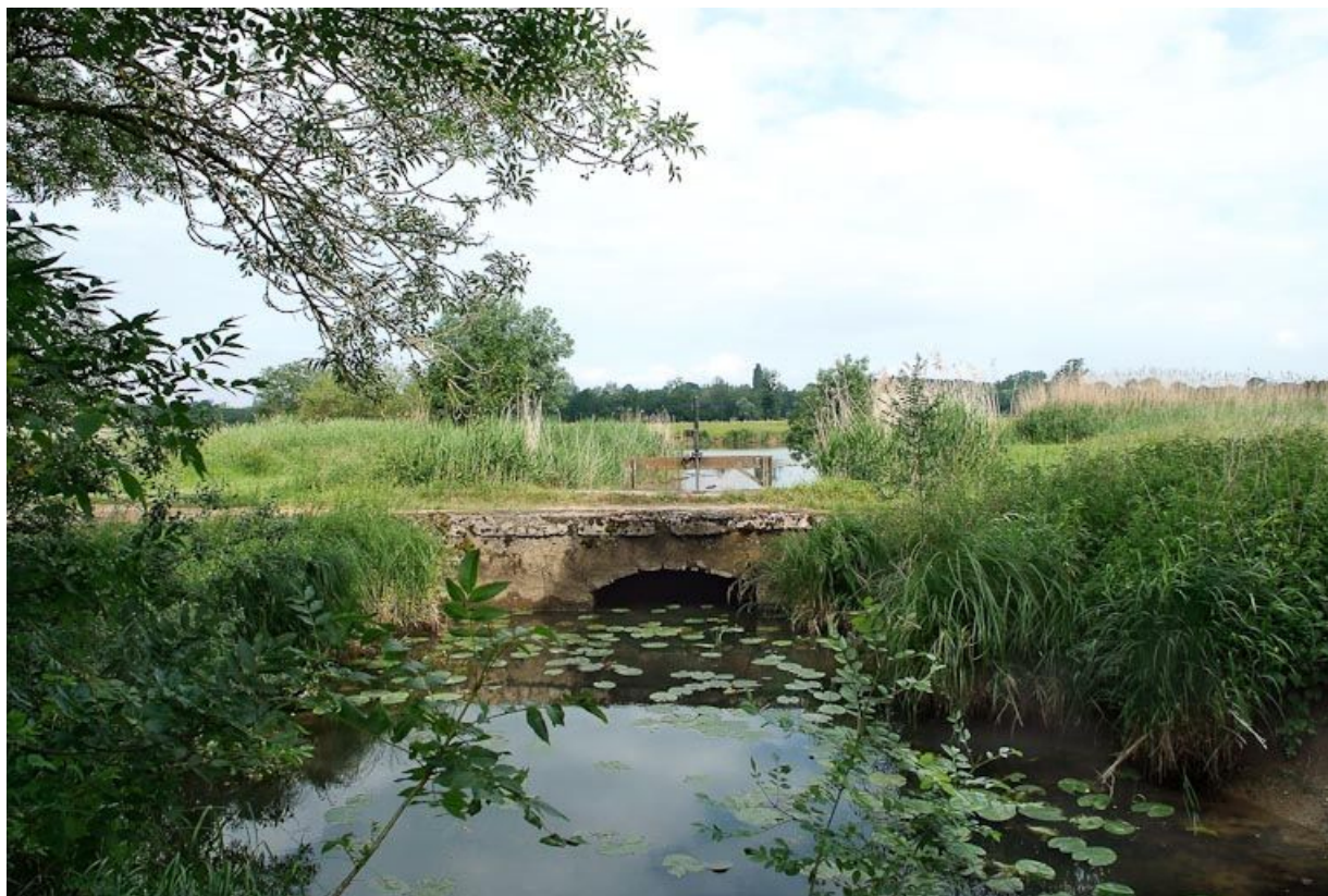
Ponceau en pierre sur un affluent de la Seille. Seille au fond, en débouché. 71, Jouvençon, lieudit : Les Mares
