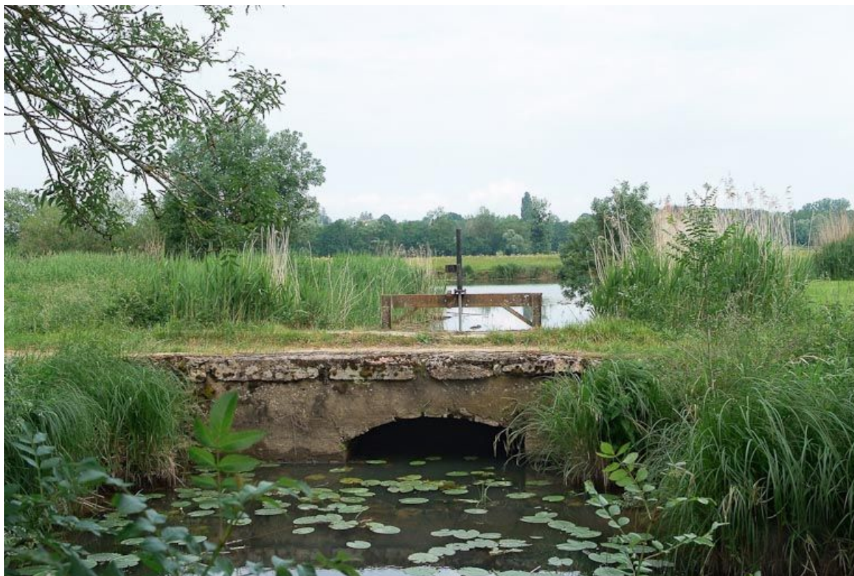
Vue rapprochée de la vanne du ponceau en pierre sur un affluent de la Seille. Seille au fond, en débouché.
