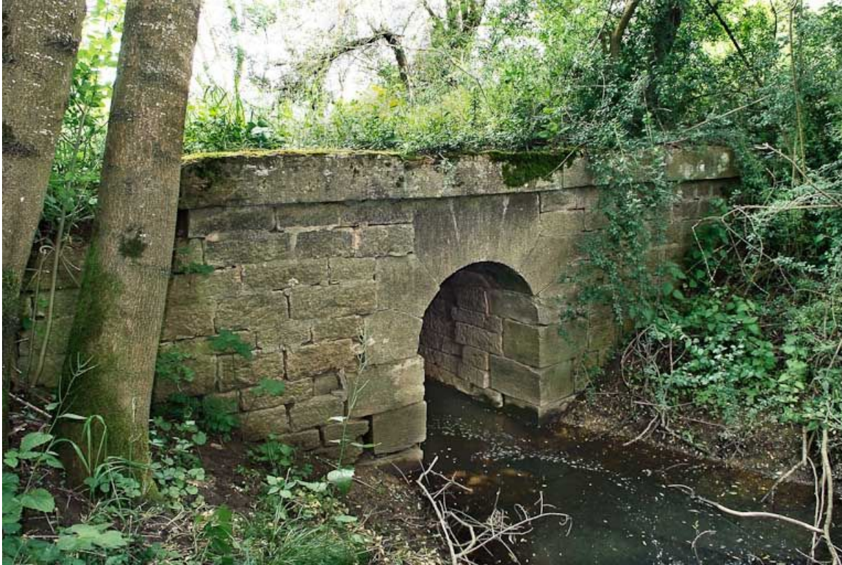
Ponceau en pierre sur un affluent de la Seille.
