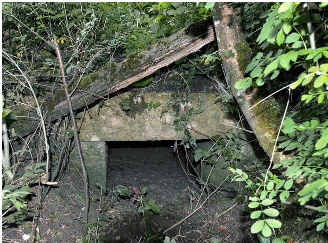
Aqueduc en pierre sur un affluent de la Seille.
