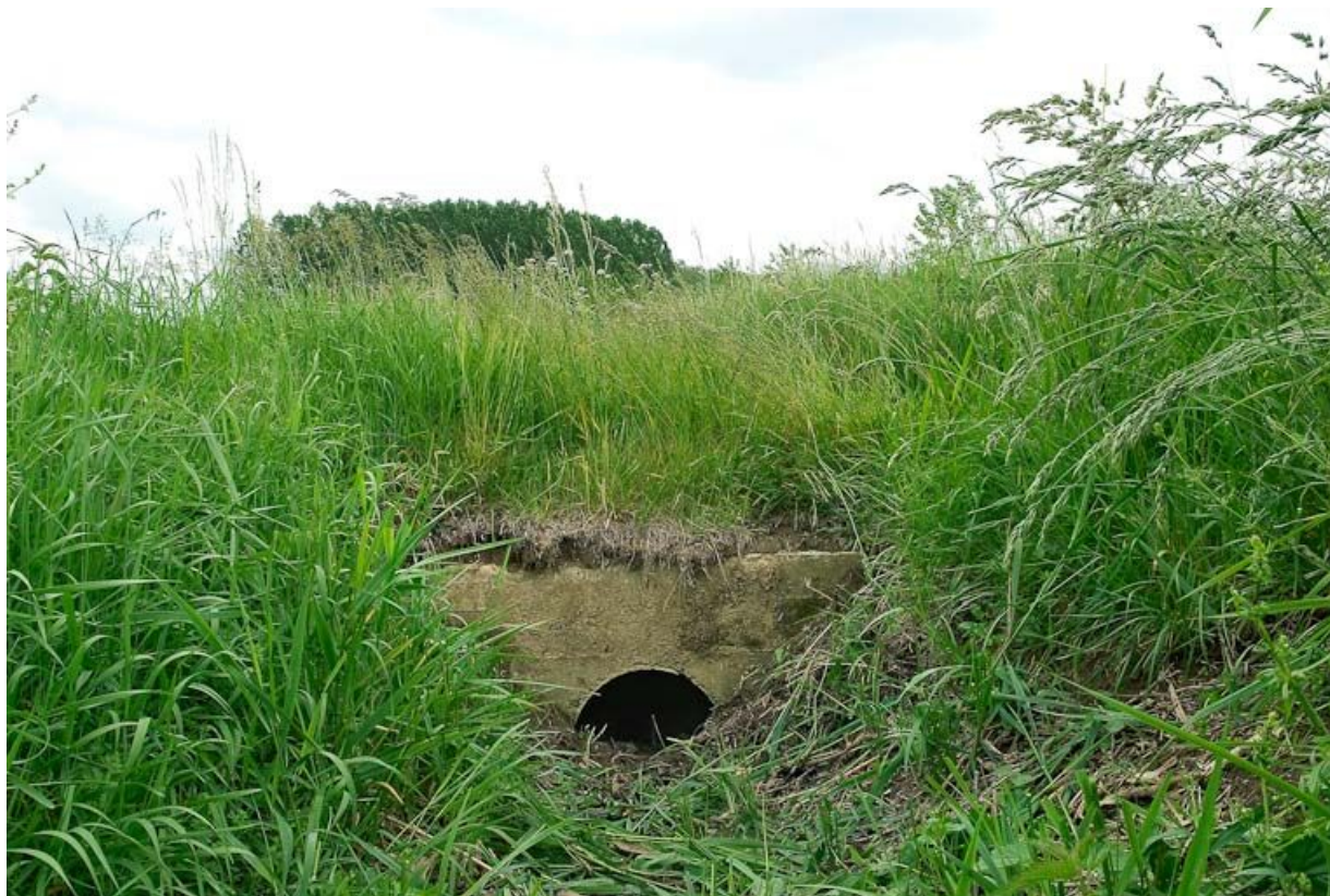
Aqueduc situé à l'endroit de l'ancien passage du bac.
