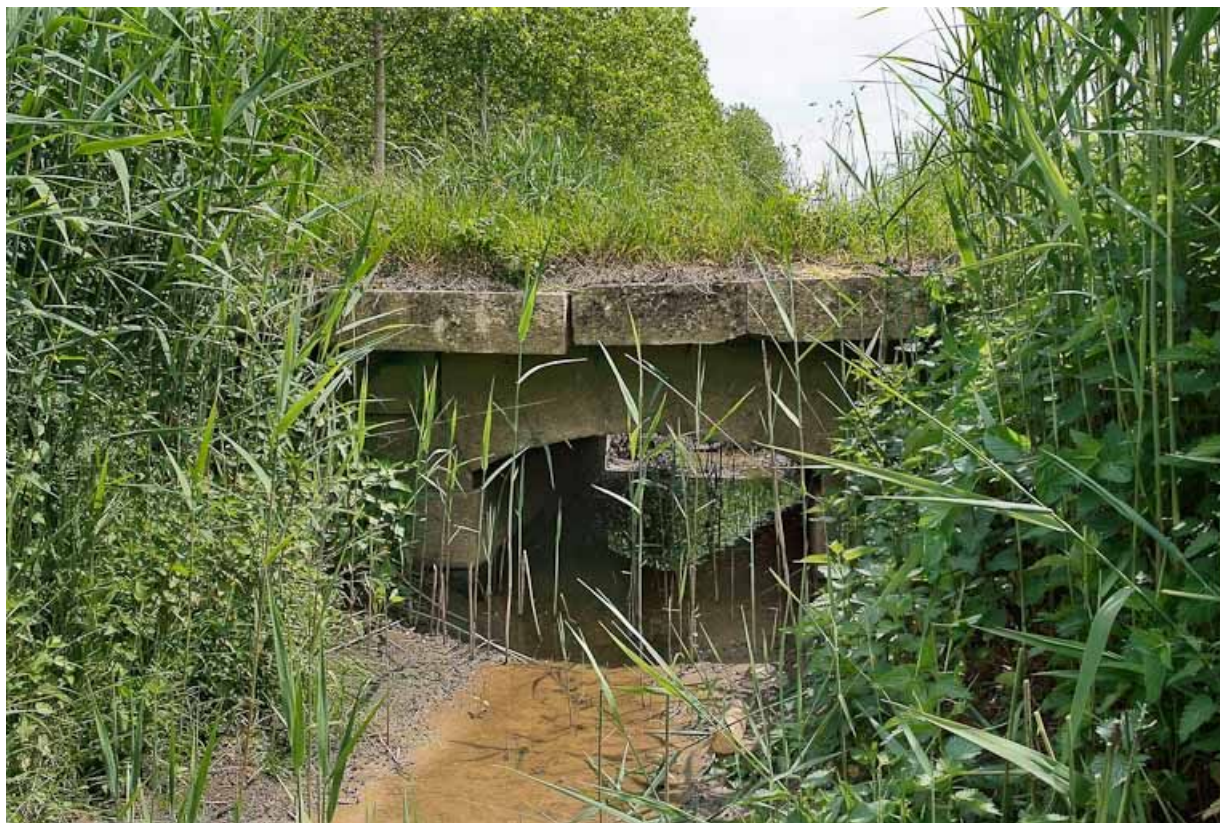
Ponceau, vue rapprochée.
