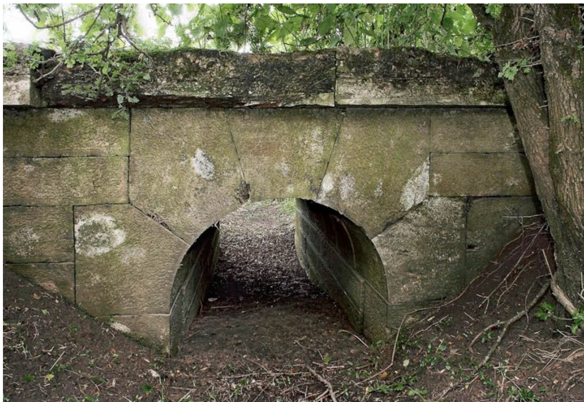
Ponceau, vue rapprochée.
