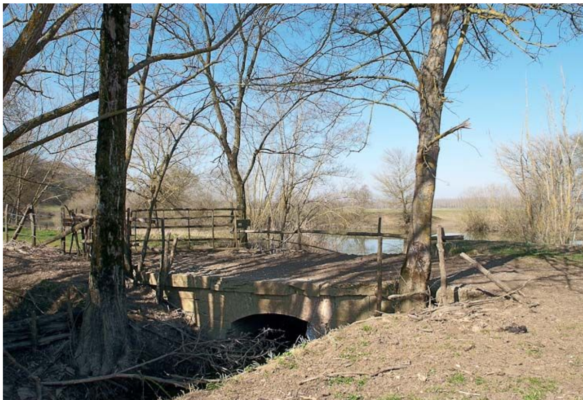
Ponceau : vue rapprochée.
