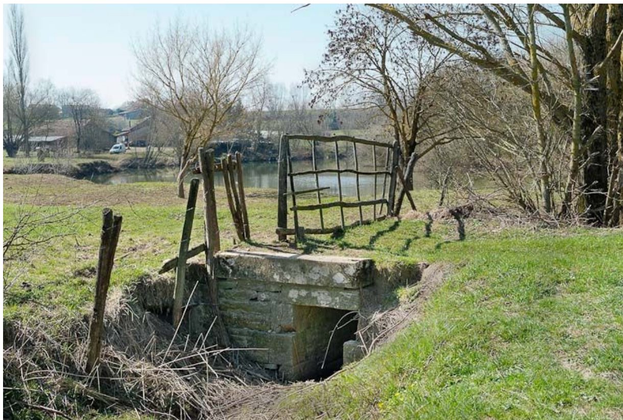
Aqueduc, vue d'ensemble avec la Seille en arrière-plan.
