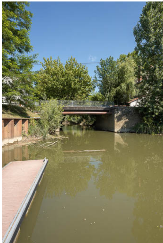
Vue d'ensemble du pont.
