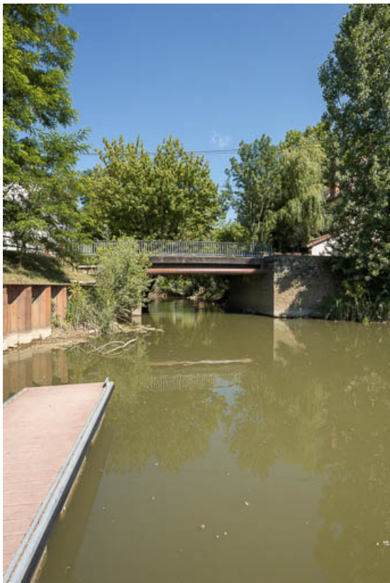
Vue d'ensemble du pont.
