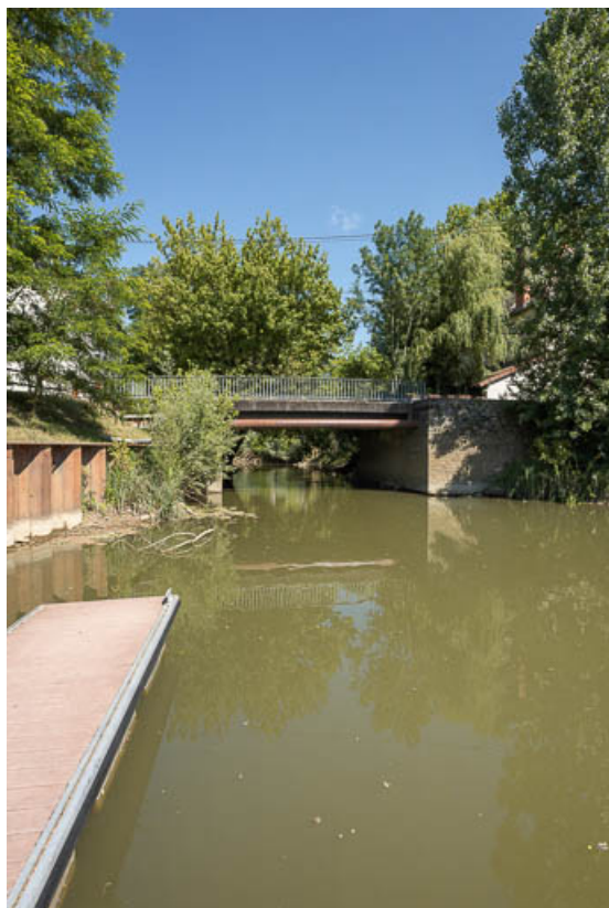
Vue d'ensemble du pont.
