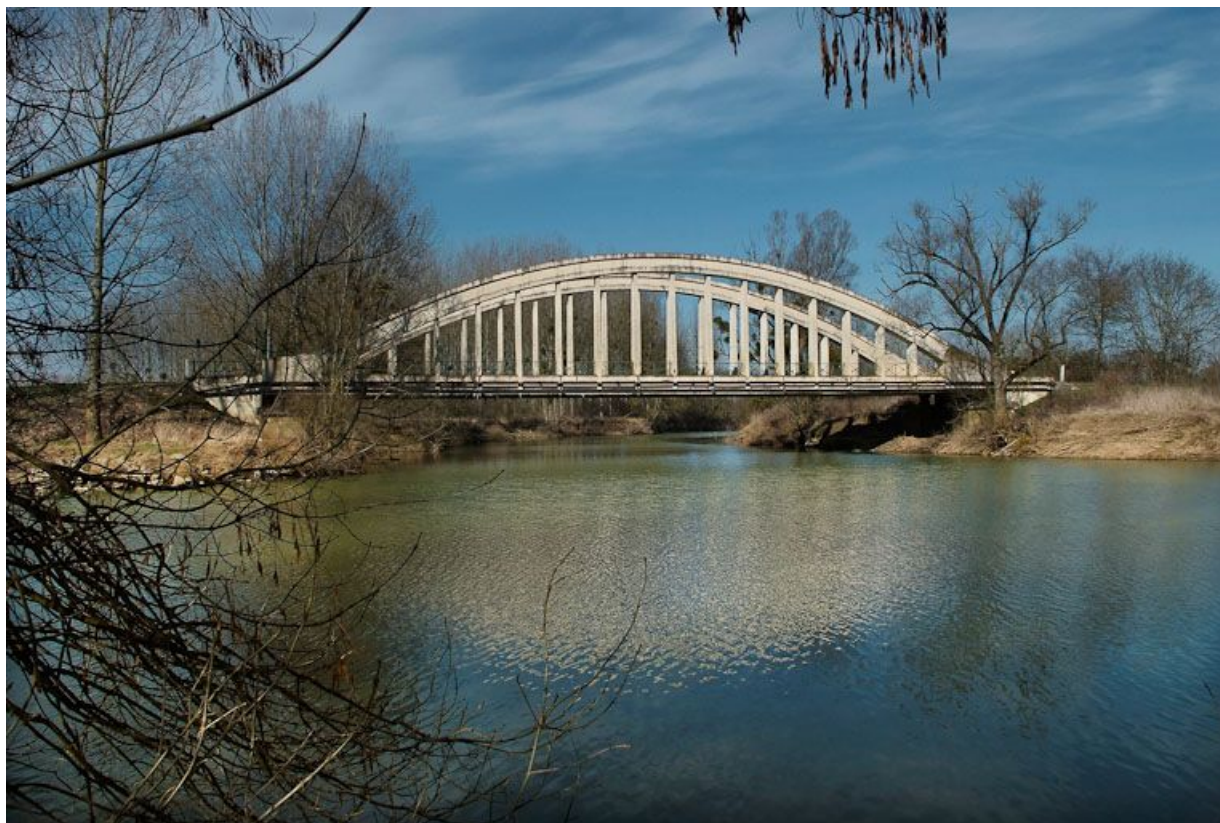
Pont de la Culée, il permet de traverser la Seille en direction de Branges.
