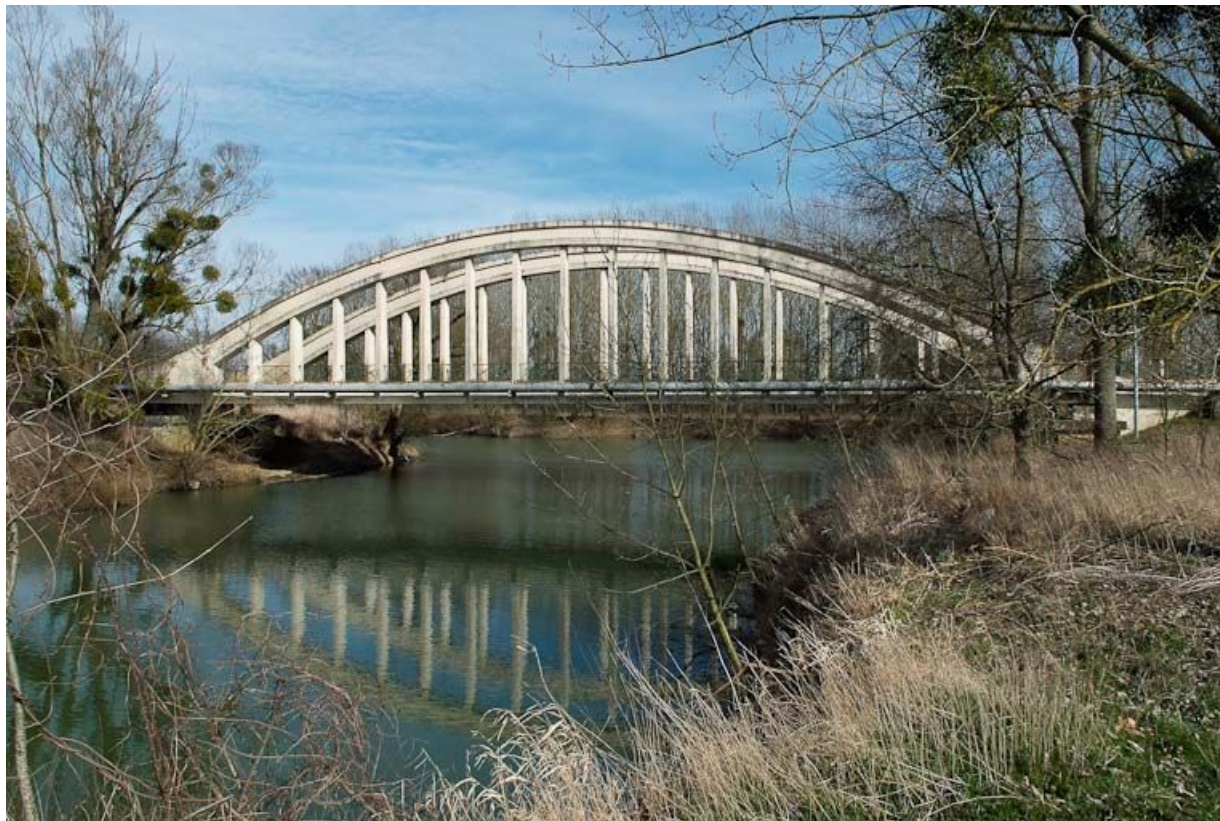
Pont de la Culée, il permet de traverser la Seille en direction de Branges.
