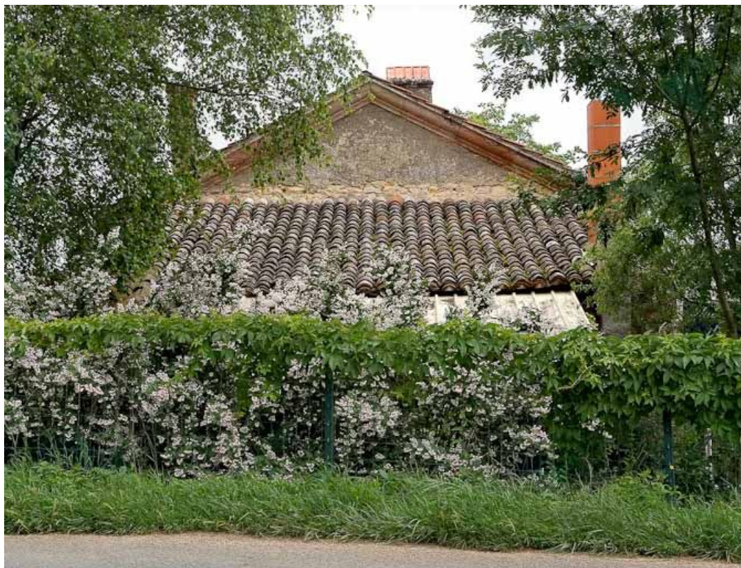
Site de l'écluse de Branges, vue du pignon de la maison éclusière.
