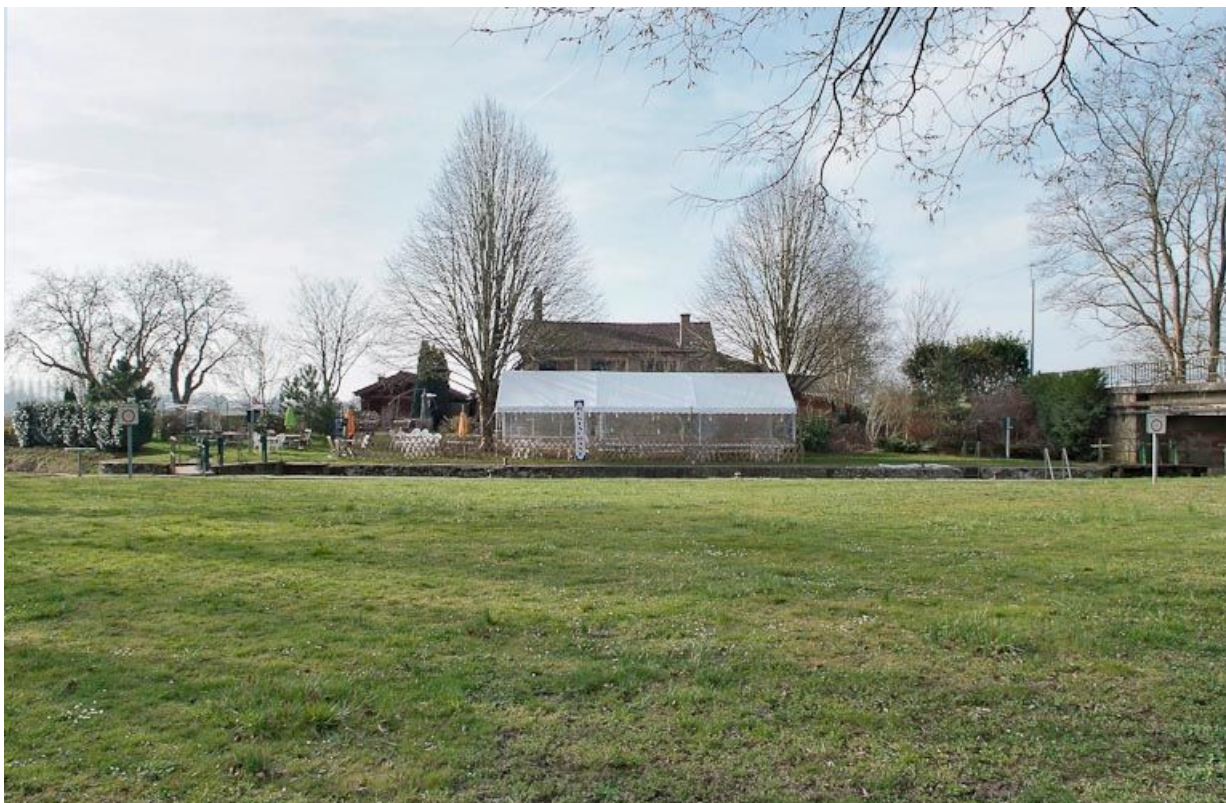
Ensemble du site de l'écluse de Branges, vu de face.
