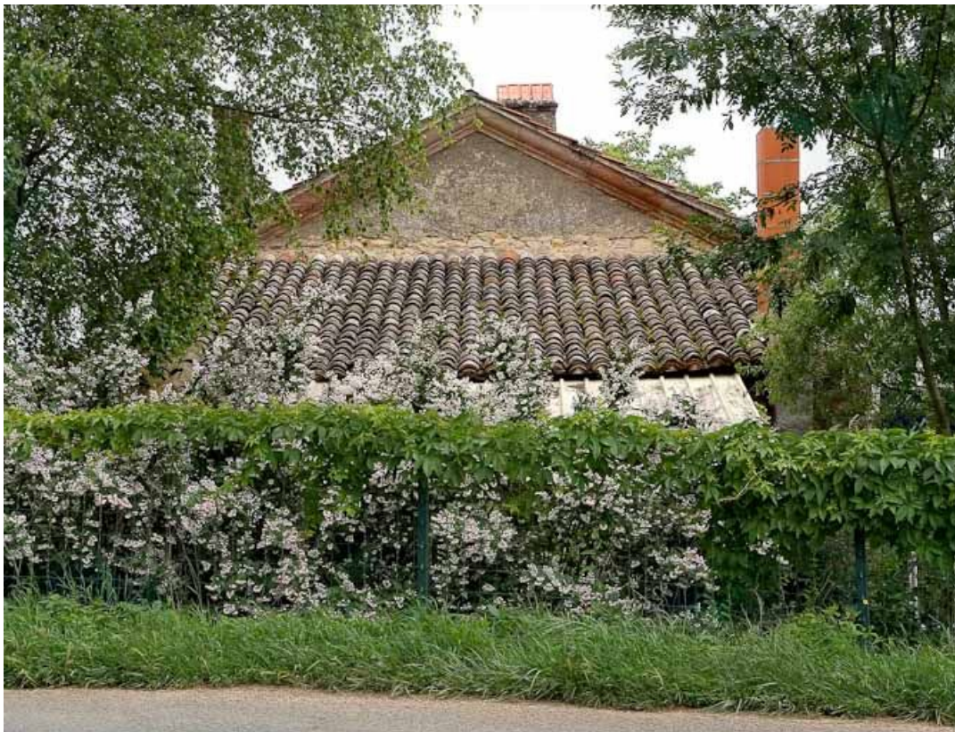
Site de l'écluse de Branges, vue du pignon de la maison éclusière.
